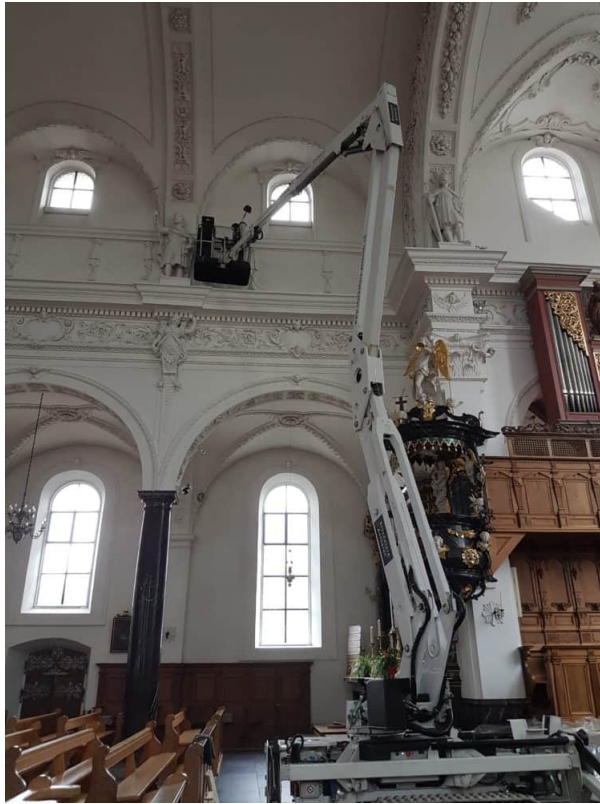
Kontrolle auch beim Kämpfergesims, Figuren, mit Feinstaubsauger auf allen Kanten und Gesimsen absaugen.
