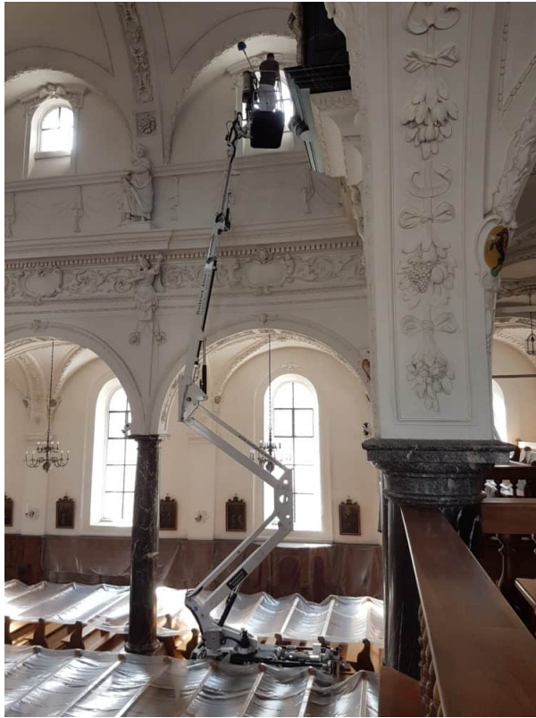
Ansicht Lift im Seitengang, Start Trockenfreilegung und Kontrolle Stuck.
