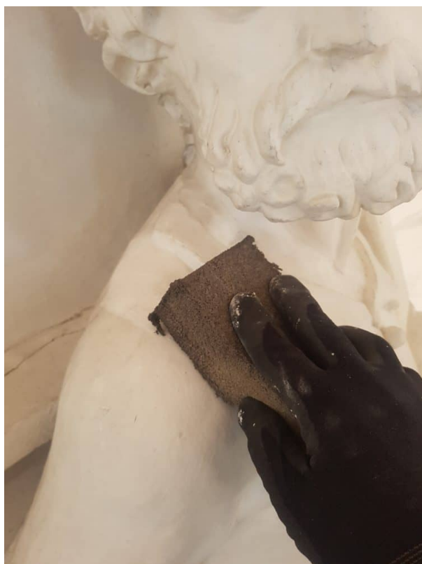
Trockenreinigung bei den Figuren auf dem Kämpfergesims.
