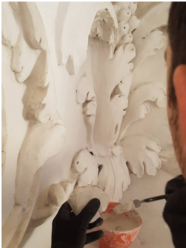
Zuputzen und Retuschen mit artgerechtem Material bei den Blumenranken.
