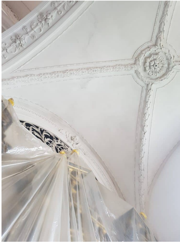
Ansicht der gereinigten Gewölbekappen in den Seitenschiffen.
