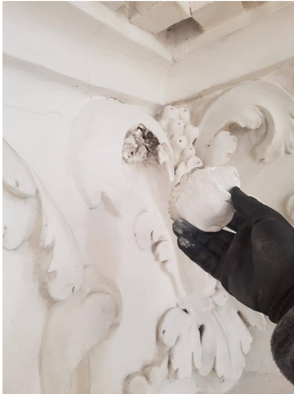
Lose Stuckteile wurden angeklebt und befestigt. Kontrolle aller Stuckteile.
