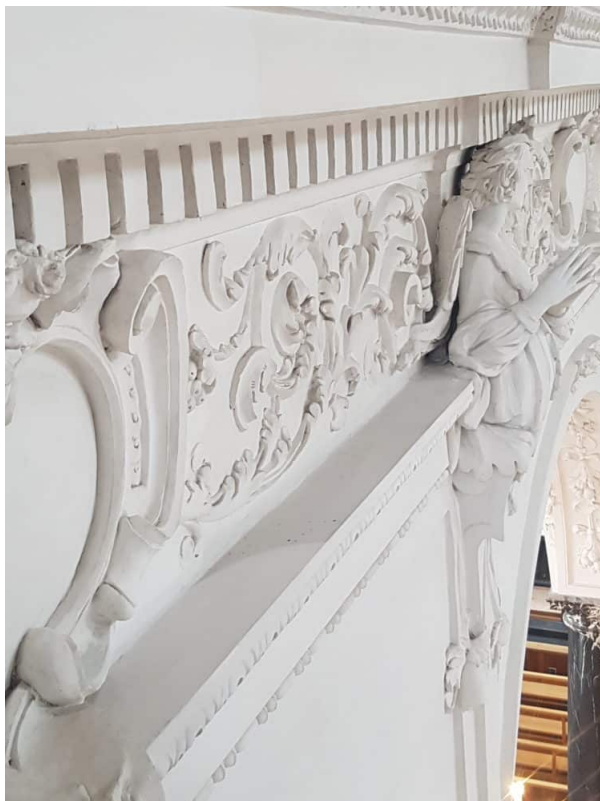
Gereinigter Zahnkranz und Blumenranken. Alles wurde mit Feinstaubsauger vorsichtig abgesaugt.
