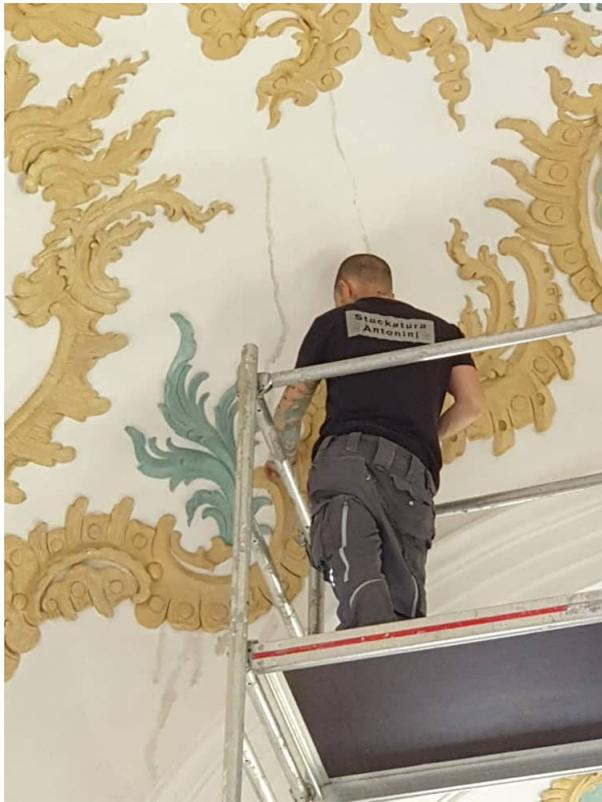
Ansicht Schiff Gewölbe: Riss Sanierung Kontrolle des Rokokostucks.
