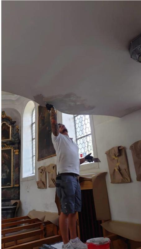
Ansicht Emporen Untersicht: Abglättung mit Kalk, Sand, Celuloce und Gips, an bestehende Oberflächen anpassen.
