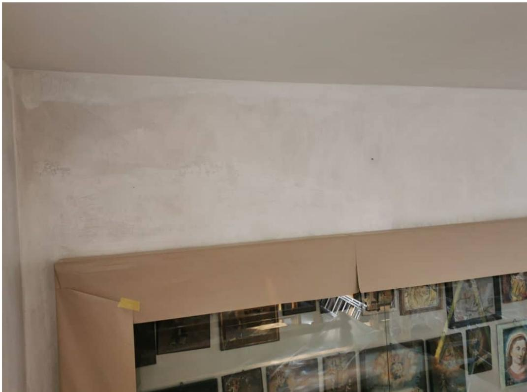
Stark verschmutzte Stellen werden mit Keim Athenit Lucente dünn örtlich mit Rosshaar Bürsten im Kreuzschlag Lasiert.
