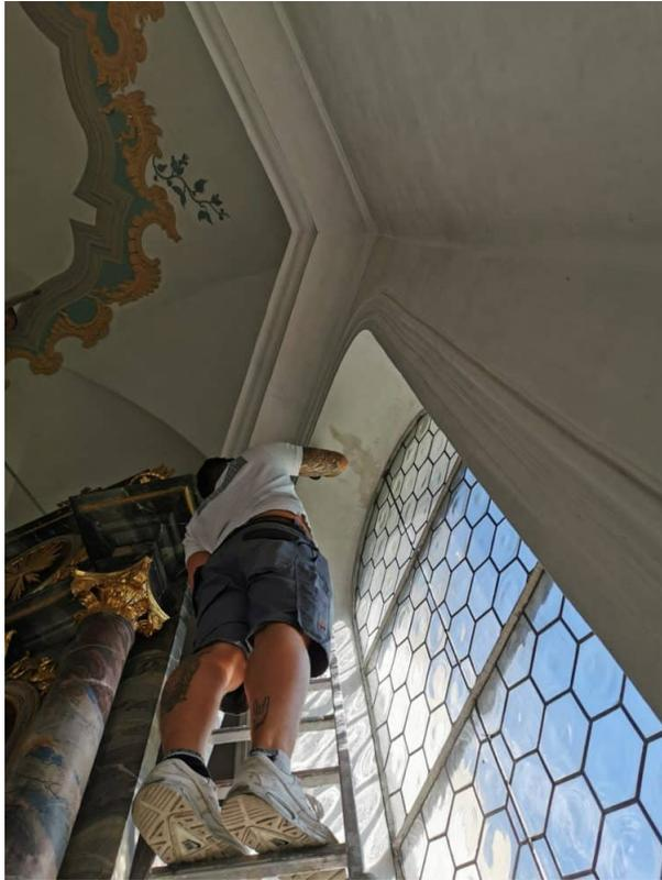
Ansicht Fenster im Chorhaus rechts: die Fenster werden mit Alkalisierem Wasser Gereinigt und Kontrolliert auf Schadstellen und Dichtungen. Riss Sanierung an den Fensterleibungen.
