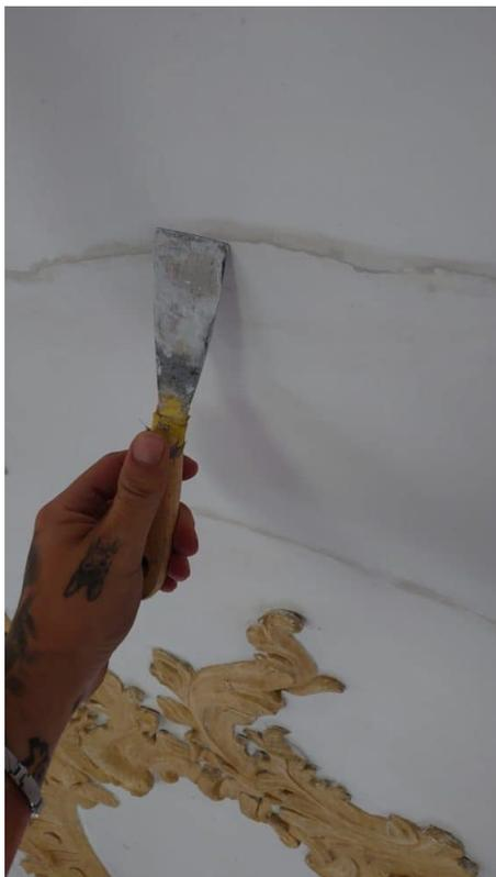
Riss Sanierung am Gewölbe mit artgerechtem Material. Kontrolle der Befestigung des Rokokostucks.
