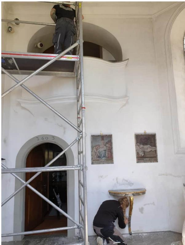
Ansicht Chorhaus: Abstoßen der Faulen und Losen Stellen, Riss Sanierung. Anschließend mit angereichertem Material an bestehende Oberflächen anpassen und zuputzen.
