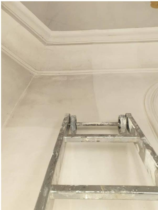
Ansicht: Trocken freilegen der Verschmutzung (Patina) mit Elastomere Latex Gummis Manuel.
