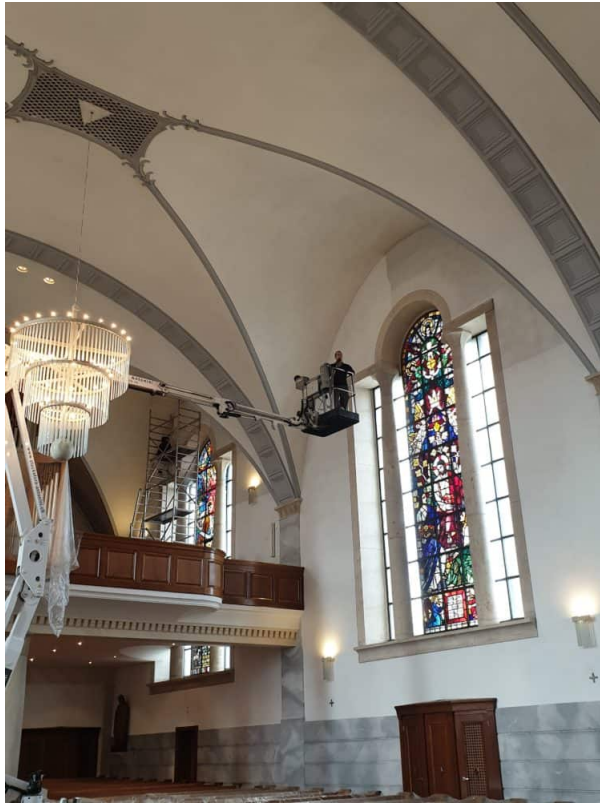
Trockenfreilegung im Schiff.
