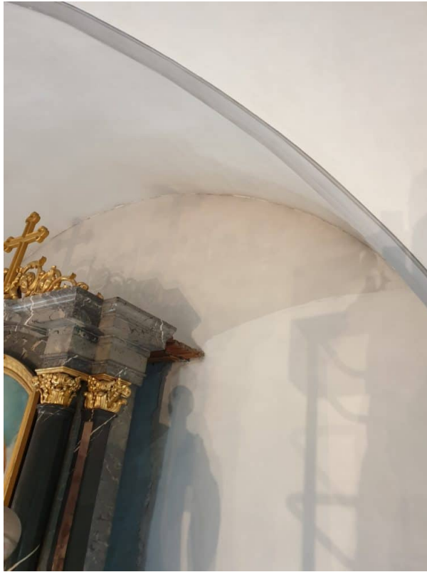
Oben verschmutzt / unten trockenfreigelegt.
