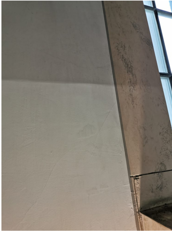
Oben Verschmutzt / unten trockenfreigelegt.
