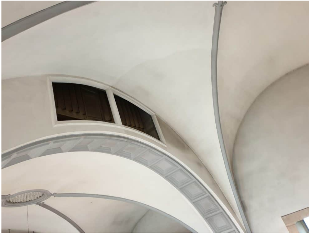
Trockenfreilegung im Chorraum Stichkappen.
