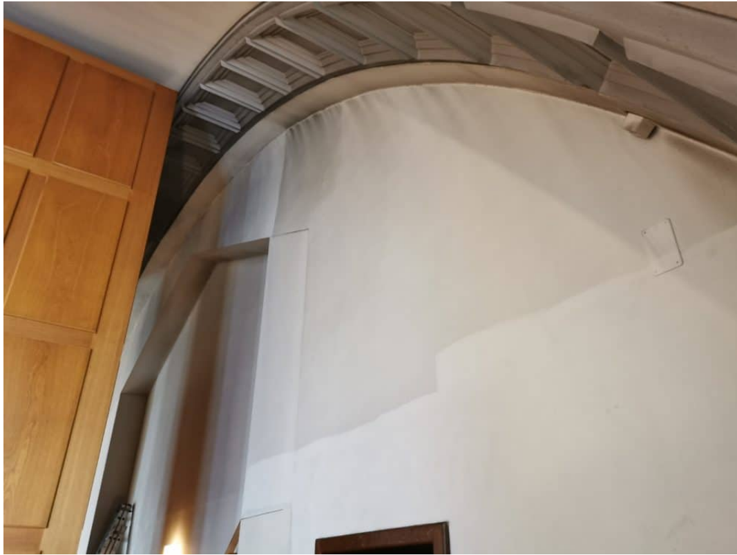
Trockenfreilegung der Rückwand auf der Empore.
