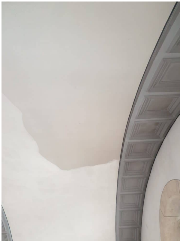
Trockenfreilegung am Gewölbe und grauen Gurten.
