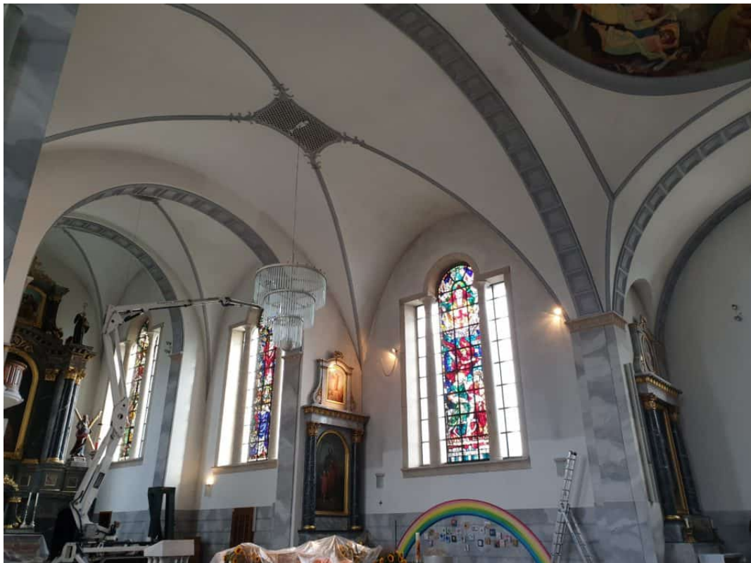
Trockenfreilegungs arbeiten mit der Spez. Hebebühne Cs 190 an den Wänden.
