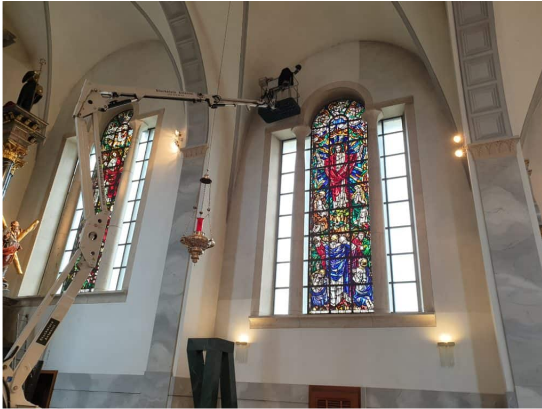
Trockenfreilegungs arbeiten mit der Spez. Hebebühne Cs 190 an den Wänden.
