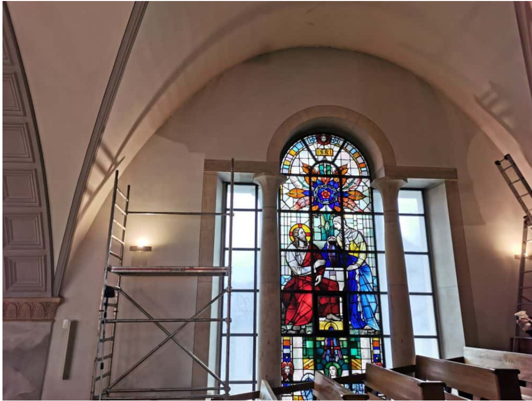
Trockenreinigung der Seiten Wände auf der Empore.
