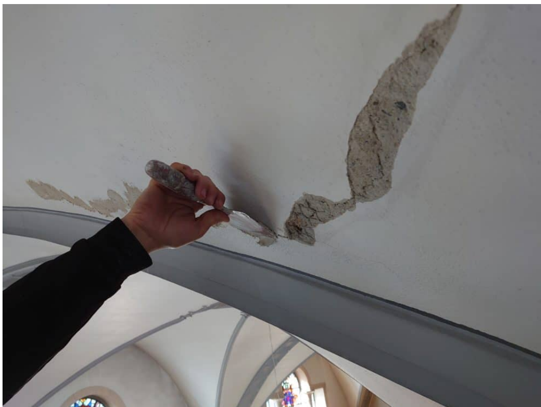
Flickstellen im Schiff am Gewölbe. Abgestossene Putz stellen werden mit artgerechtem Material zugeputzt.
