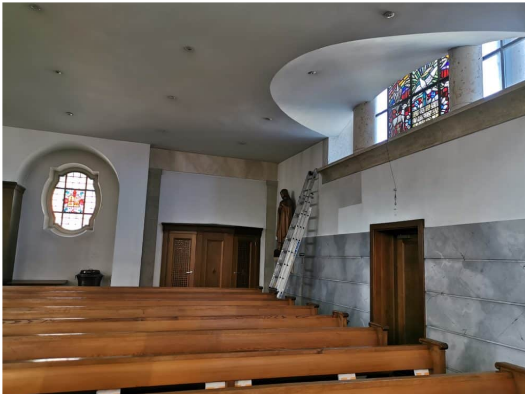
Trockenfreilegung unter der Empore Wände und Untersicht.
