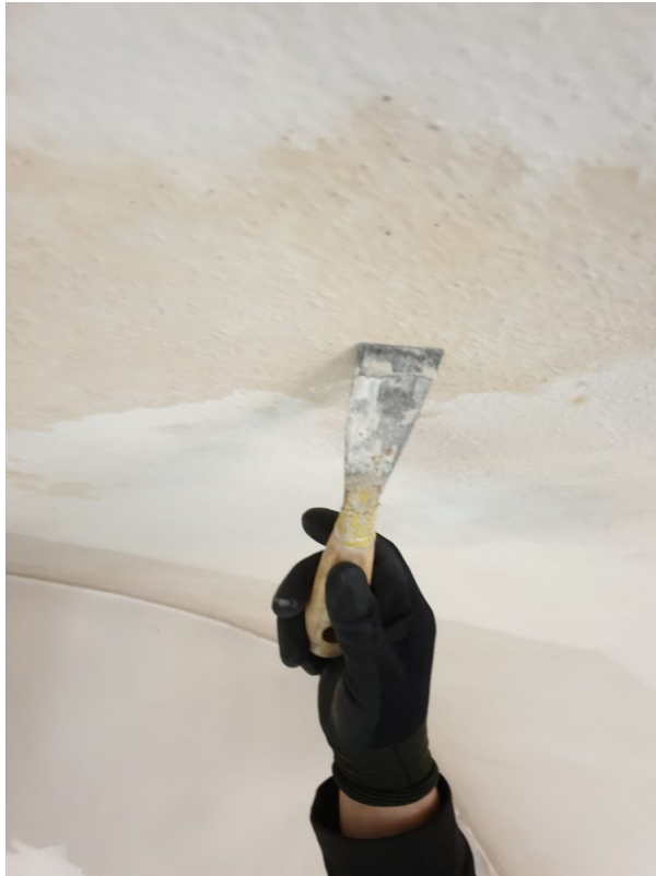
Faule und Lose Putzstellen werden abgestossen und mit artgerechtem Material zu geputzt, und örtlich mit Keim Mineral Farbe ausretuschiert.
