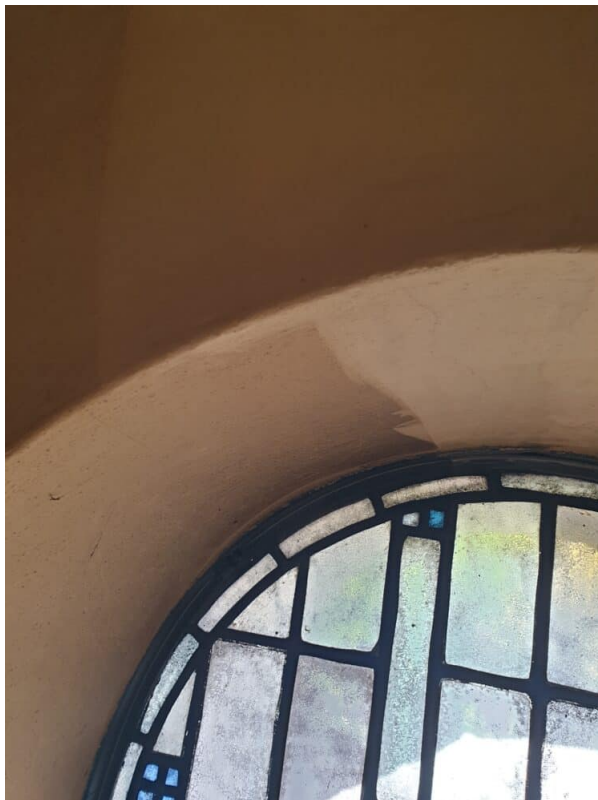
Trockenreinigung Fenster Leibungen. Anschliessend Reinigen der Fenster Kontrolle Dichtungen.
