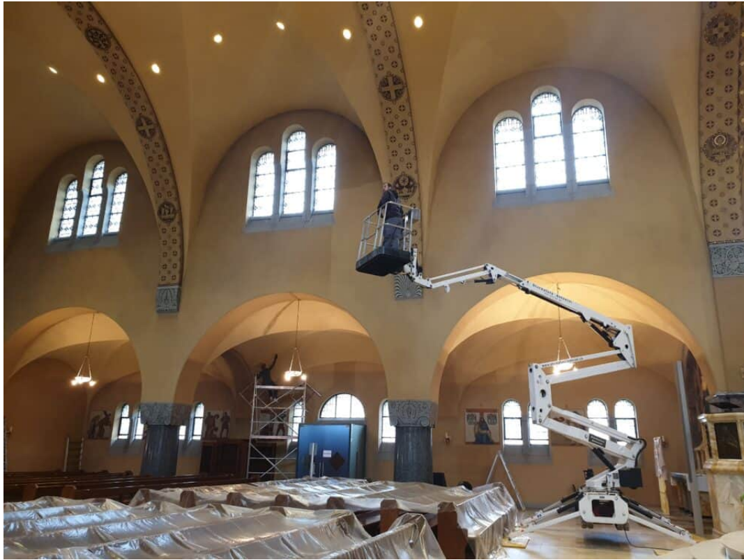
Ansicht Trockenfreilegen der Verschmutzung mit der Spezial Hebebühne CS 170.
