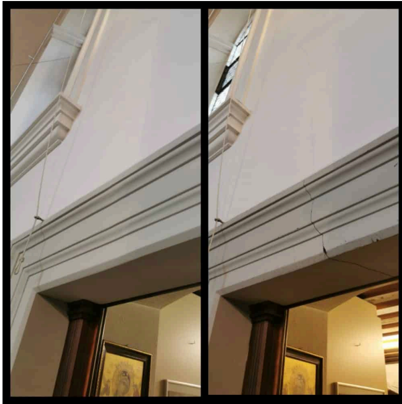
Eingang zur Nebensakristei Die gemalene Sandstein Tür Umrahmung wurde mit Artgerechtem Material Geflickt und aussretuschiert.
