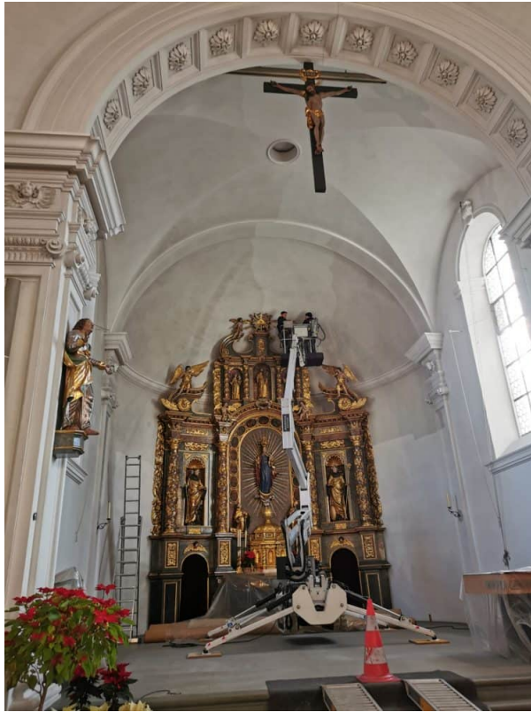
Trockenreinigung in der Kirche St.Gallus Kriens Luzern. Die letzte Trockenreinigung der Raumschale liegt ca. 8 Jahre zurück. Die Patina ist gleichmäßig über alle Wandoberflächen und Ausstattung überzogen.
