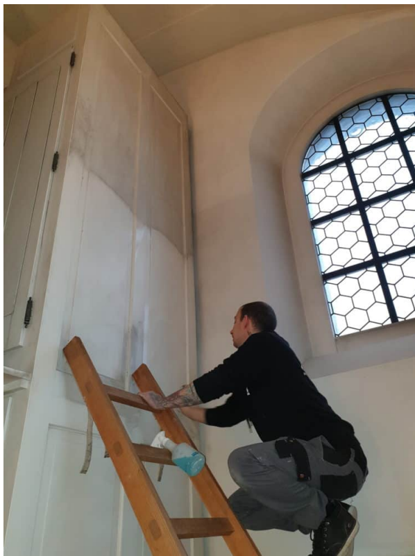
Reinigung des Hinteren Orgelgehäuses. Oben verschmutzt / unten gereinigt.
