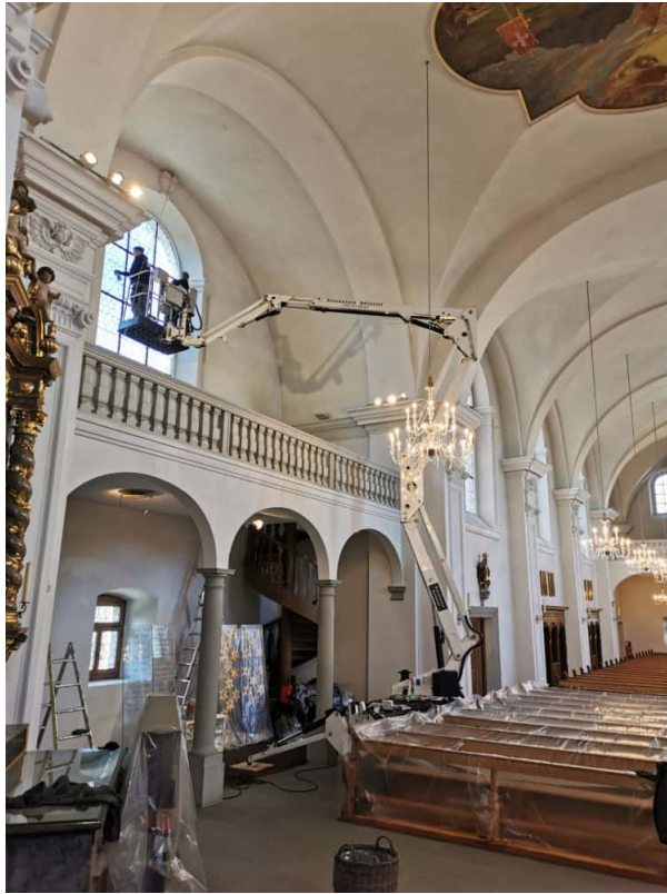
Fenster Reinigung in der gesamten Kirche.
