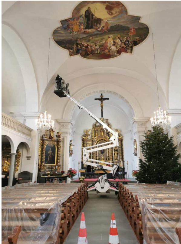
Trockenfreilegung im Schiff. Sämtliche Bänke werden mit Fein Plastik abgedeckt.
