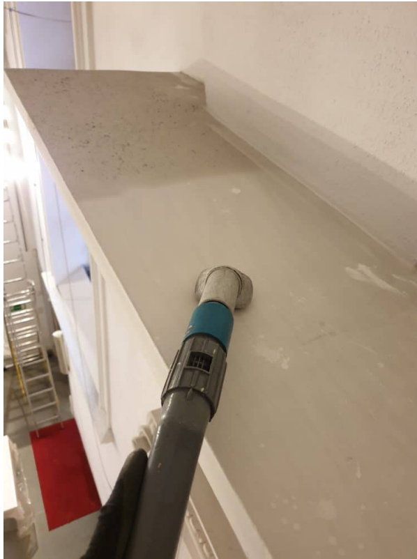
Absaugen aller Oberflächen. Gesimse, Fensterleibungen, Stuckaturen, Hochaltar, Seitenaltäre, Kanzeldeckel, Orgelgehäuse
