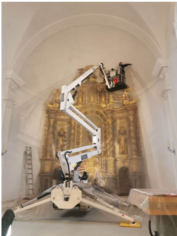
Das Gewölbe oberhalb des Hochaltars wurde frisch wie bestehend mit Leimfarbe neu lasiert.
