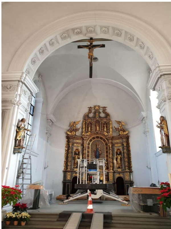
Trockenreinigung im Chorhaus mit der spez. Hebebühne cs 190.
