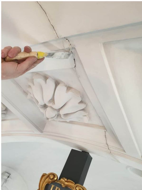
Risse Im Chorbogen (Gewölbe) werden keilförmig geöffnet und anschließend mit Artgerechtem Material zugeputzt und örtlich mit Mineral Farbe ausretuschiert.
