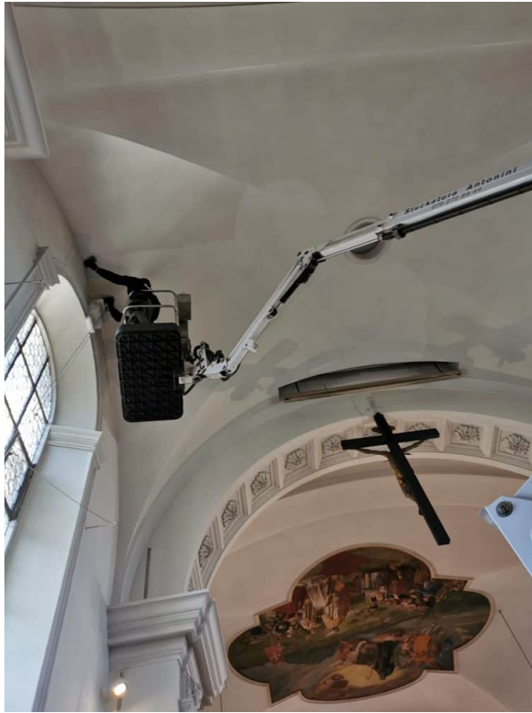
Trockenfreilegung mit der Hebebühne CS 190 im Schiff am Gewölbe.
