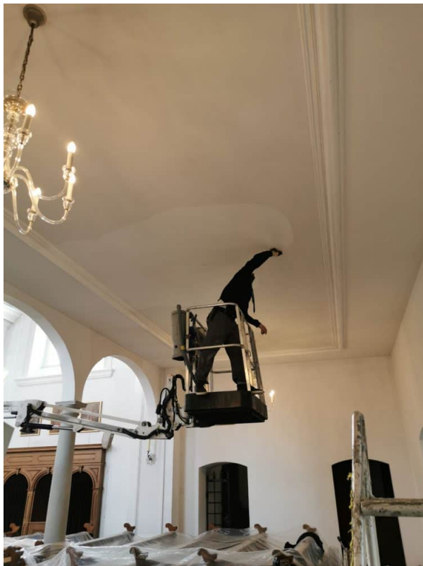
Trockenreinigen der Emporenuntersicht Beim Haupteingang.
