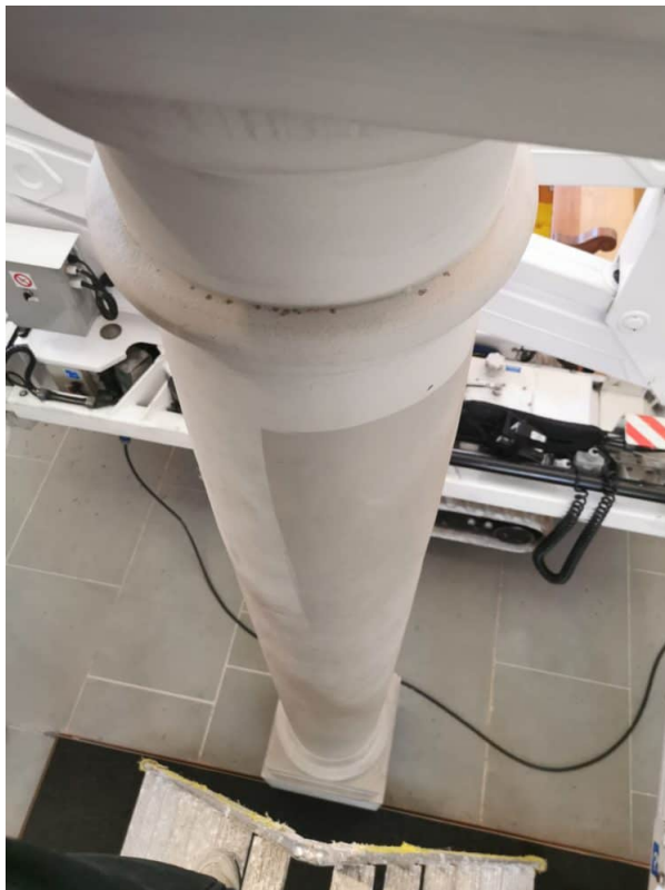
Trockenreinigung an bemalten Sandstein Säulen.
