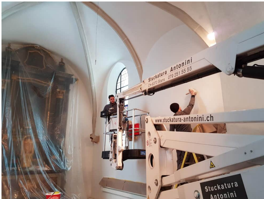
Anstricharbeiten im Chorhaus dünne Lasur der Aussenwände und Gewölbe
