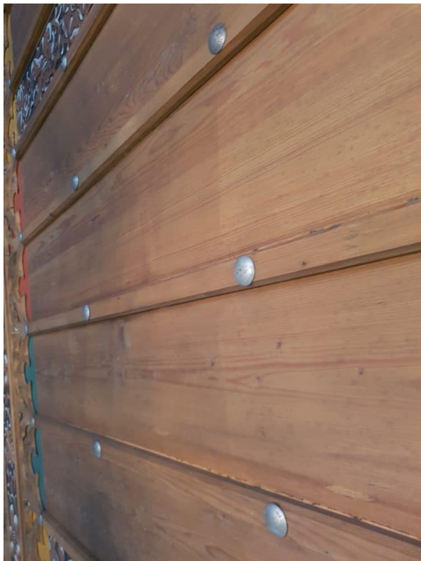
Trockenreinigung an der Holzdecke
