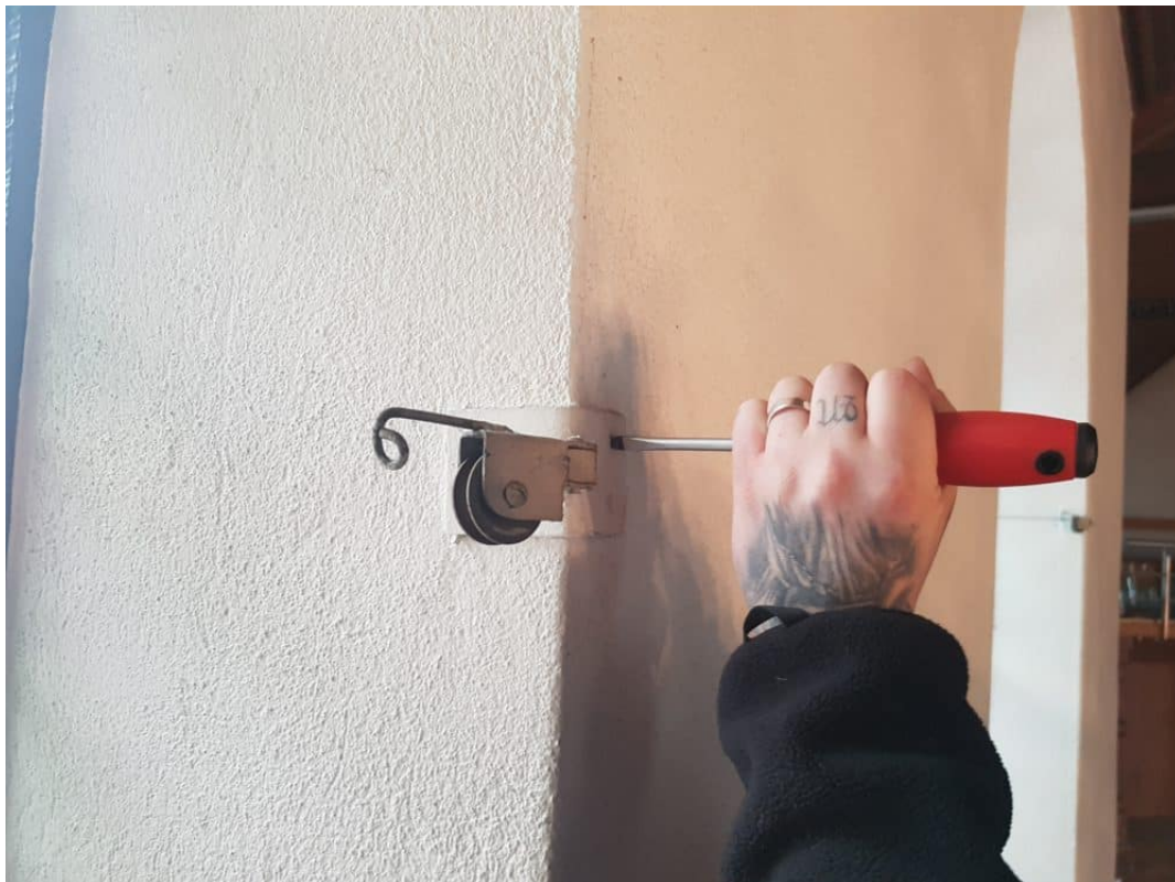
Entfernen der alten Fensteröffner
