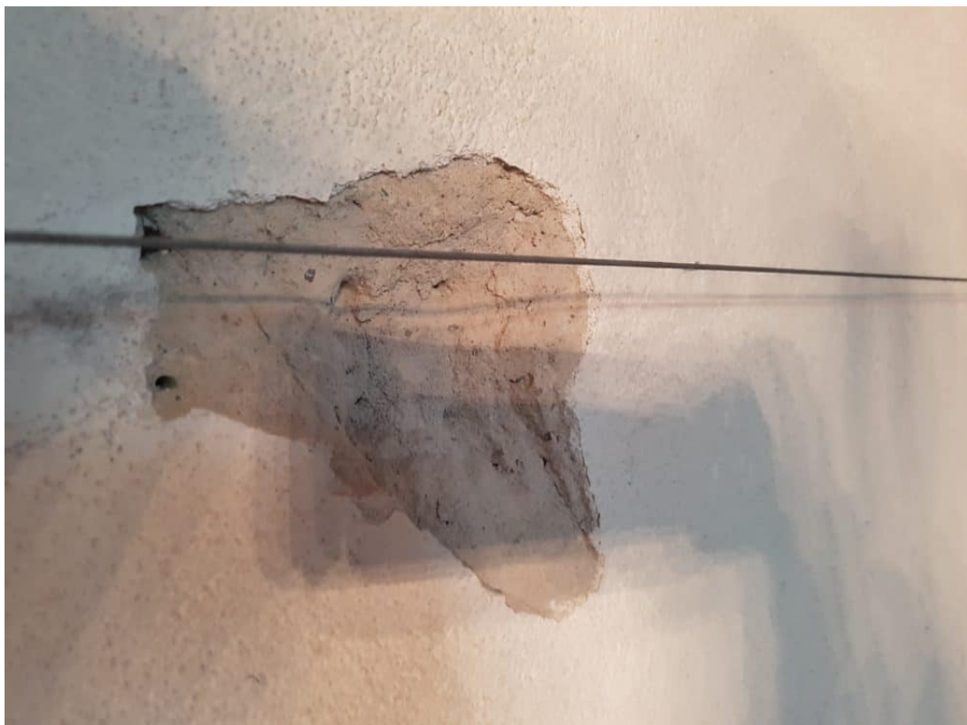
Zuputzarbeiten angleichen an bestehende Oberflächen
