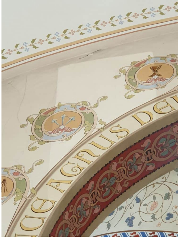
Ansicht Bemusterung Chorbogen. Trocken freilegen der Patina (Verschmutzung)
