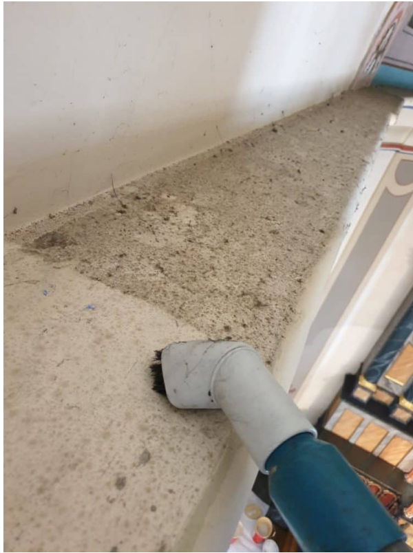
Absaugen aller Oberflächen, reinigen der Ausstattung, wie Altäre, Kanzeldeckel Bilder, Kreuzwegbilder Orgelgehäuse, gesamtes Holzwerk.
