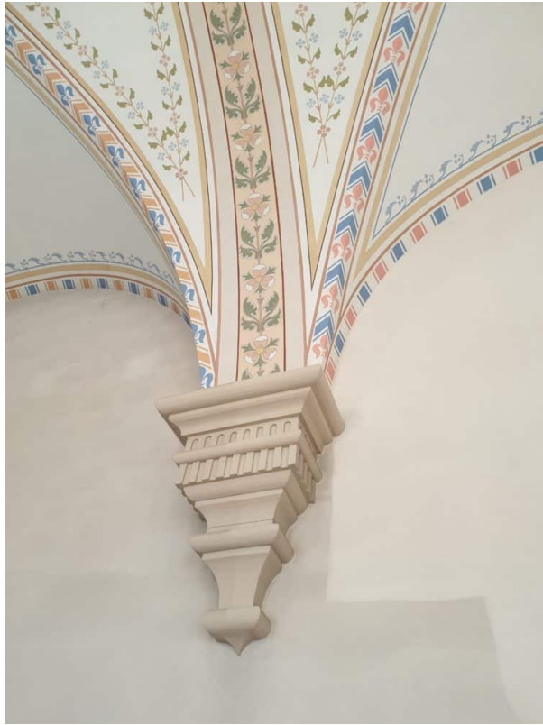
Ansicht Schiff Langhaus: Links verschmutzt / rechts gereinigt
