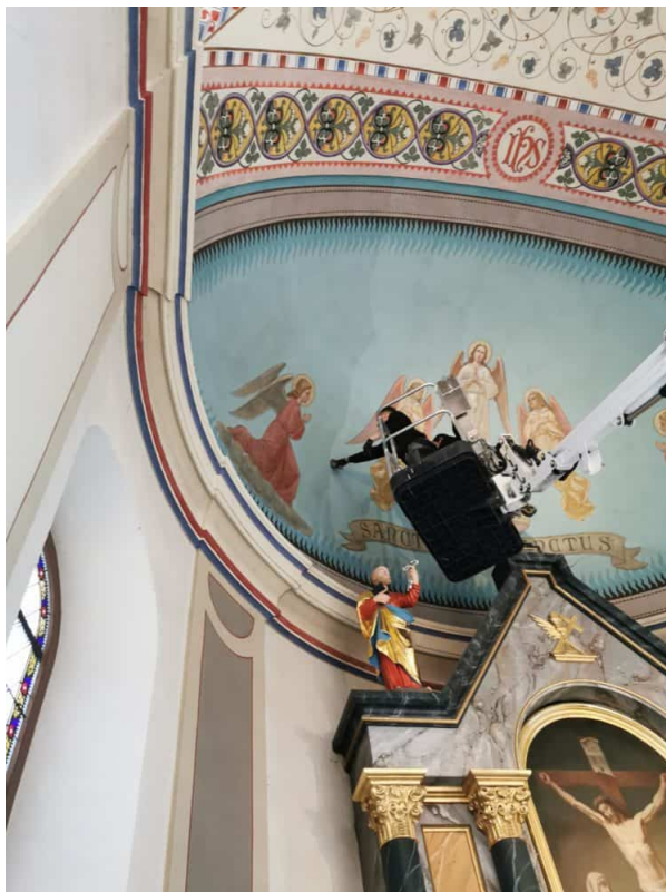
Freilegen der (Patina) Verschmutzung im Chorgewölbe Vorsichtiges Reinigen an den Bildern und Schablonen Malereien.
