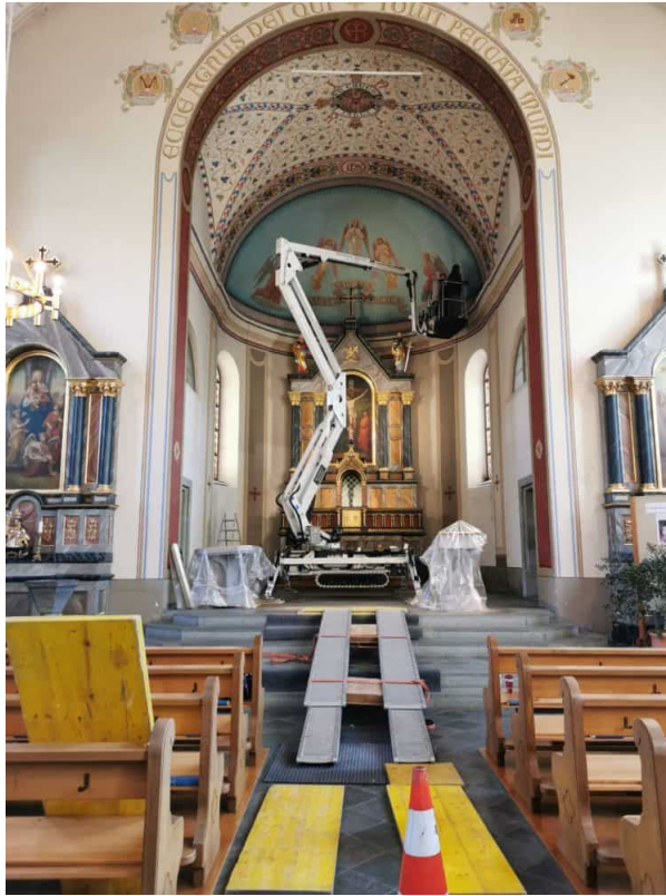
Ansicht Trocken freilegen der Verschmutzung im Chorhaus. Die gesamte Raumschale der Kirche St. Jakobus Uffikon wird mit speziellen Latex Gummis, (Elastomere) Trocken gereinigt. durch die Reinigung entfernen wir Russ und Staubpartikel an allen Wand und Gewölbe Flächen, für den Wert Erhalt der Kirche.
