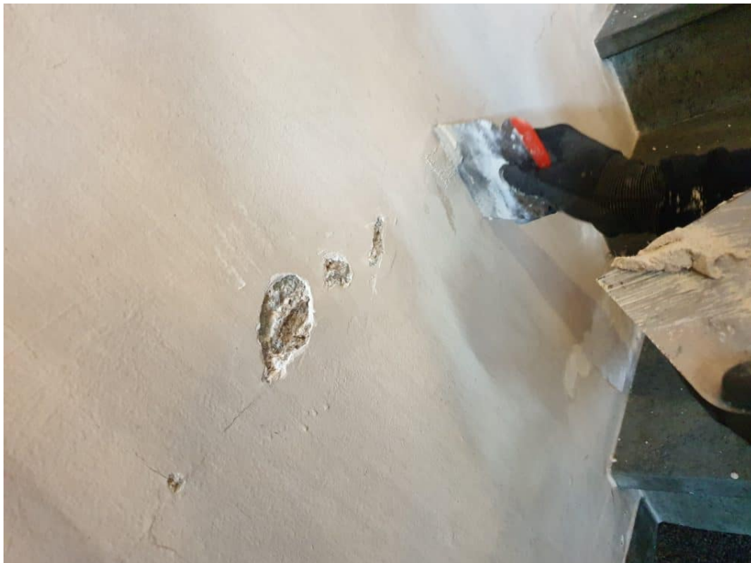
Abplatzungen und Faule stellen werden abgetragen und mit artgerechtem Material an bestehende Oberflächen angeputzt. Anschließend mit Keim Mineral Farbe örtlich ausretuschiert.
