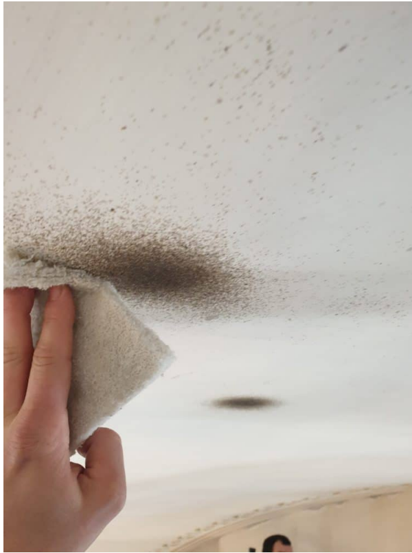
Der Fliegen Kot wird leicht Feucht abgetragen und anschließend Isoliert. Für die Eindämmung des Lockstoffes werden speziellen Algiciden eingestrichen.
