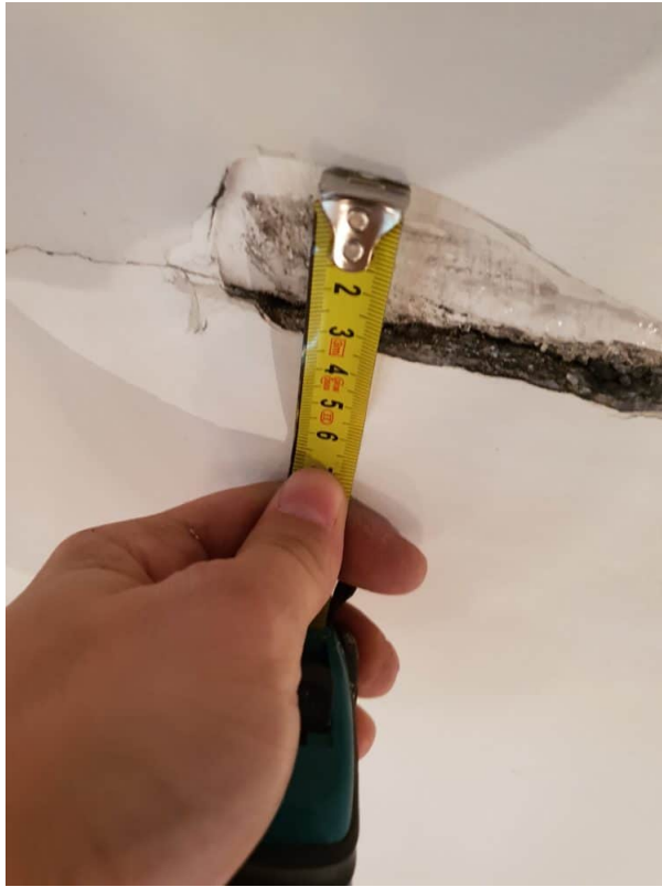
Ansicht der offenen Flickstelle Breite 3.5 cm. Der Untergrund wurde vom Staub gereinigt und leicht feucht genetzt.
