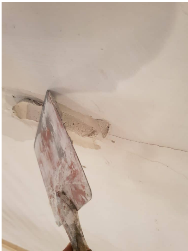
Die Flickstelle wurde mit artgerechtem Material zugeputzt. Sauberes anputzen an bestehende Oberfläche und Abglättung.
