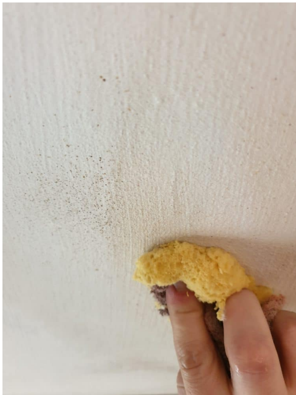
Entfernen der Fliegen Kott Stellen am Gewölbe.
