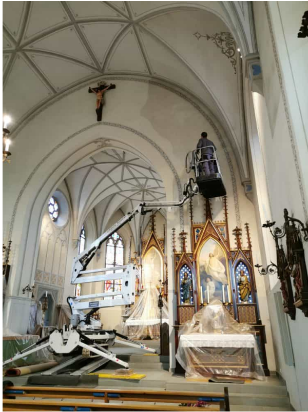
Trockenfreilegung beim Chorbogen. kleinere Risse werden mit artgerechtem Material zu geputzt an bestehende Oberfläche und mit Keim Mineral Farbe örtlich aus retuschiert.
