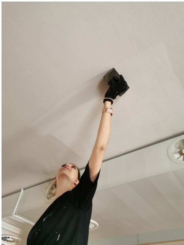
Trockenfreilegung der Untersicht zur Orgel Empore.
