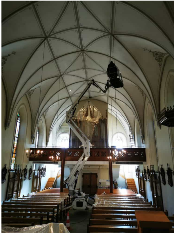
Trockenfreiliegung am Gewölbe.
