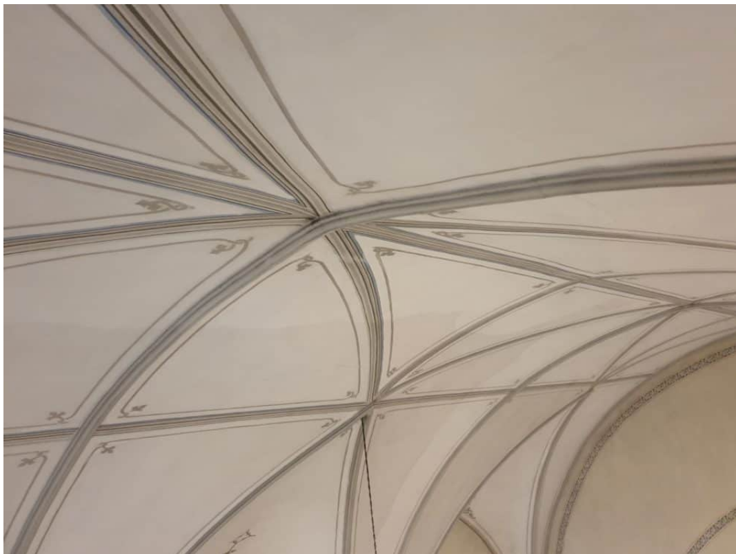
Trockenfreilegung am Gewölbe im Schiff.
