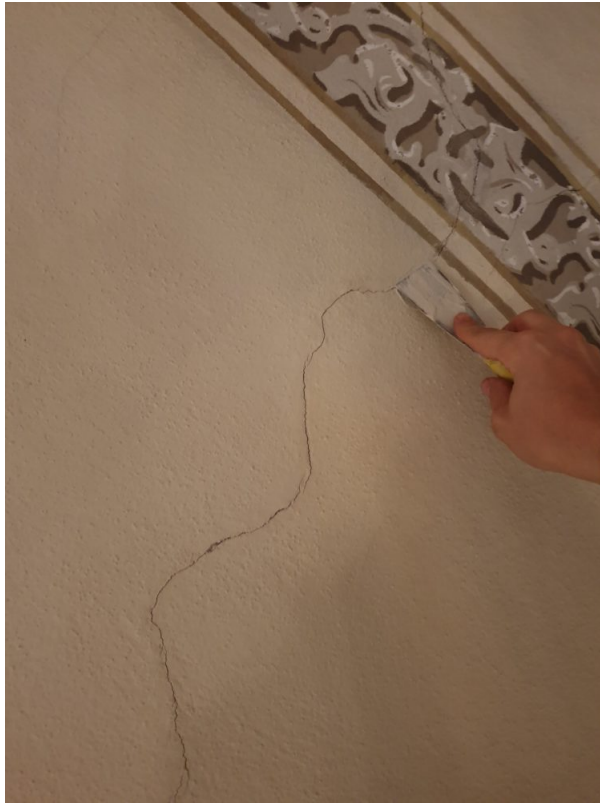
Riss Sanierung mit Artgerechtem Material.
