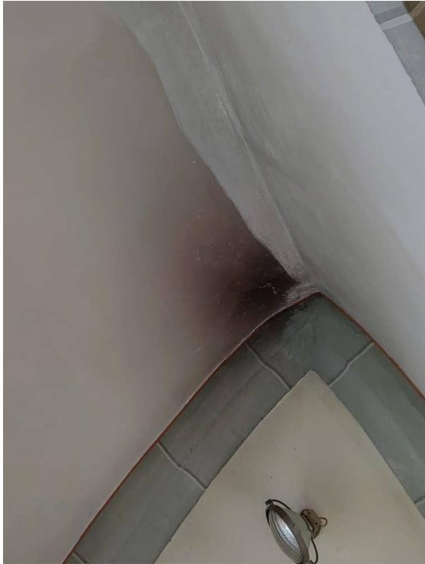
Trockenfreilegung der Stichkappen im Chorraum. Durch die Hitze der Leuchter entstehen örtlich strake schwarze Flecken.
