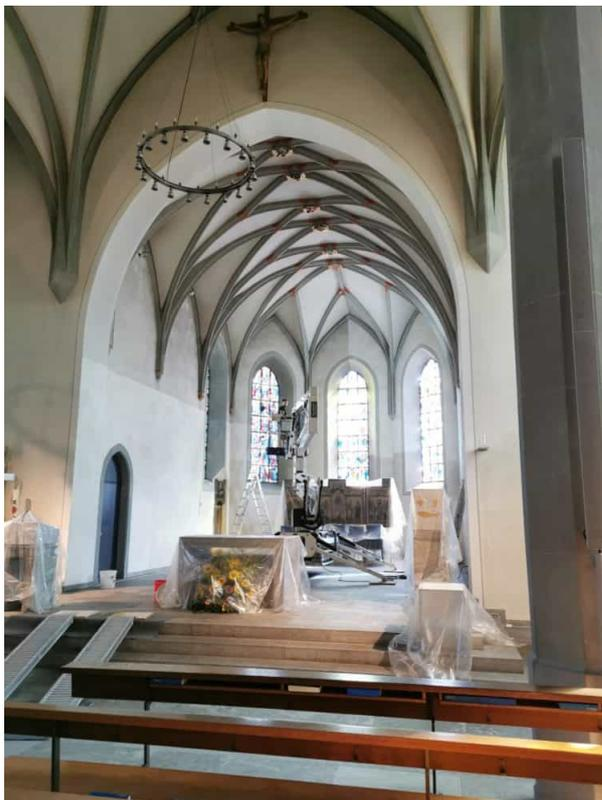
Trockenfreilegung und leicht feuchtes nachwaschen der Wandoberflächen.
