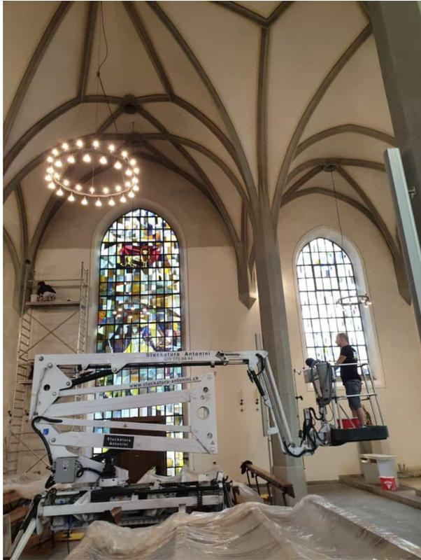
Trockenfreilegen mit Spez. Hebebühne CS 170
