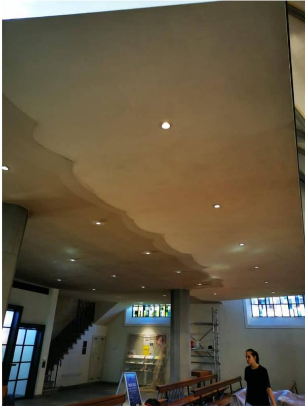
Trockenfreilegung und feuchtes nachwaschen der Emporen Untersicht.
