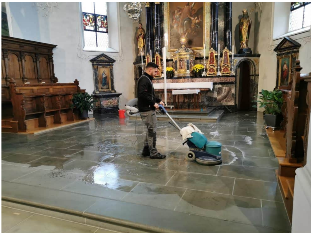
Mit der Einscheibe Maschine wird der Sandstein tiefengereinigt.
