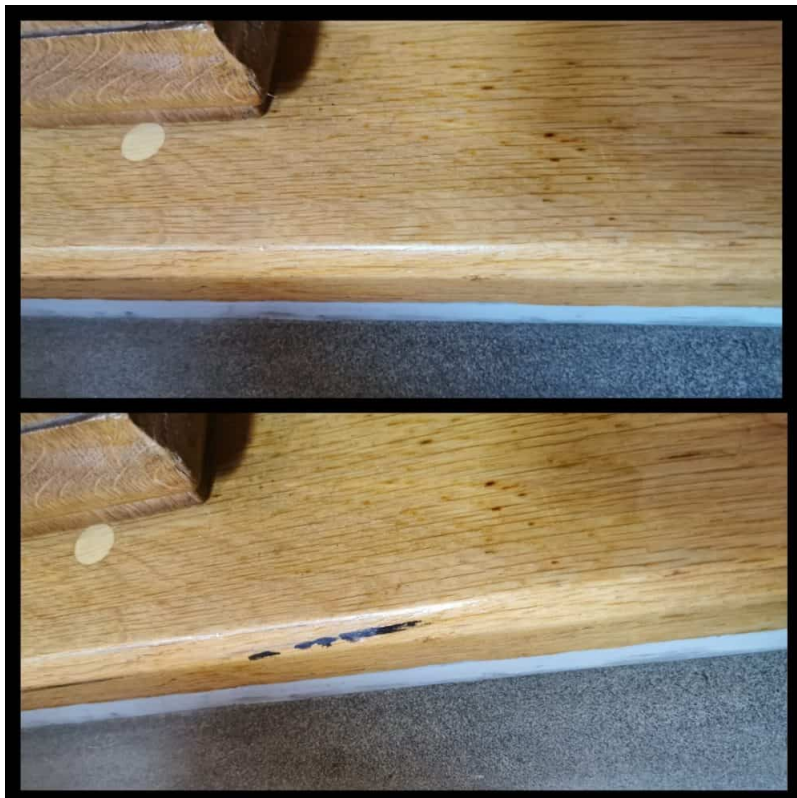
Entfernen schwarzer striche im Holzboden.
