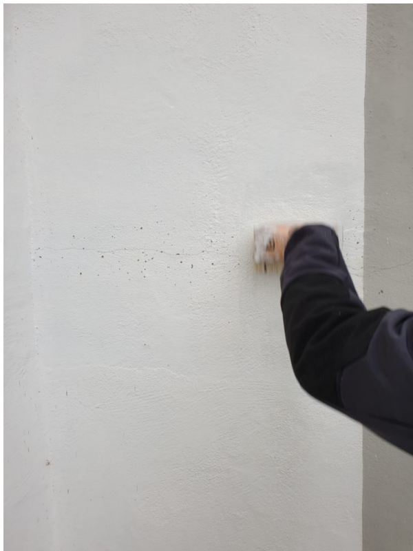
Flecken und geflickte Stellen werden mit Keim Mineral Farbe örtlich gemischt und mit Rosshaarbürsten lasiert.
