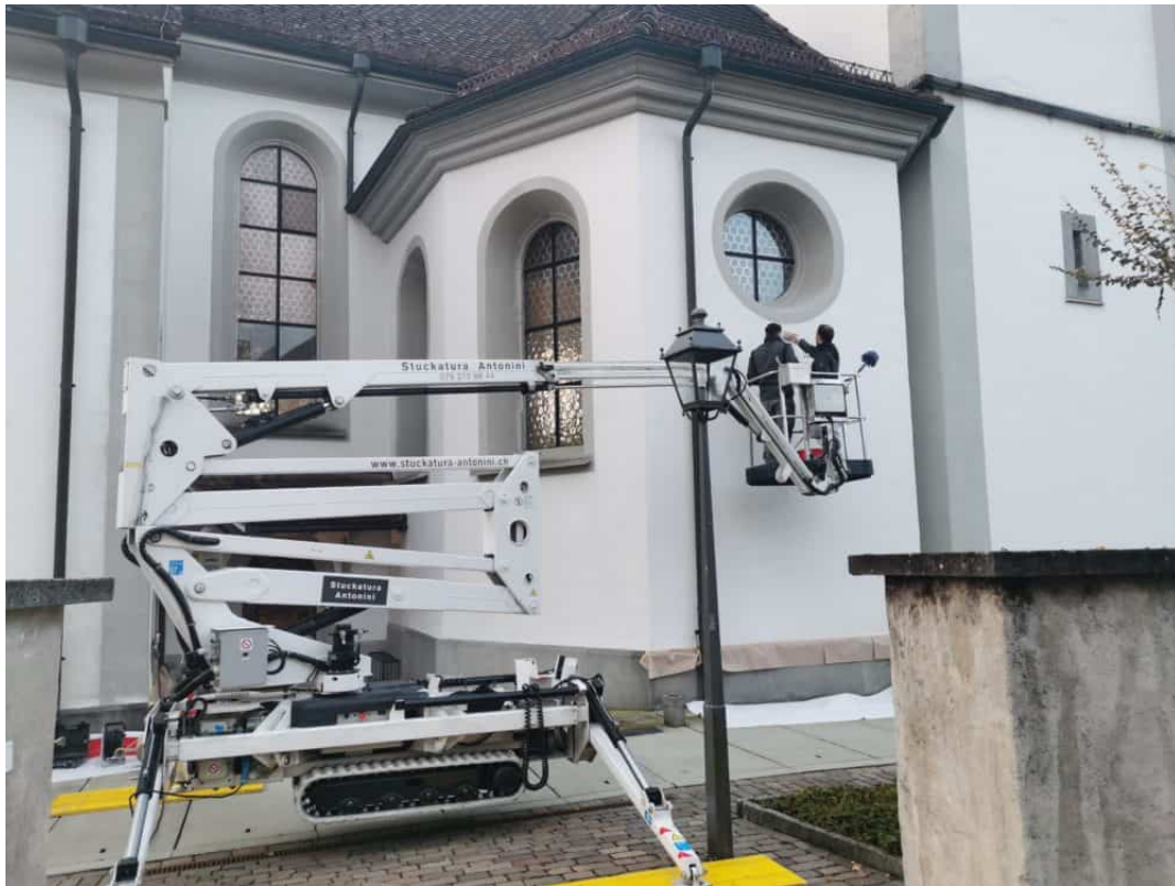
Fenster Reinigung im Aussenbereich.
