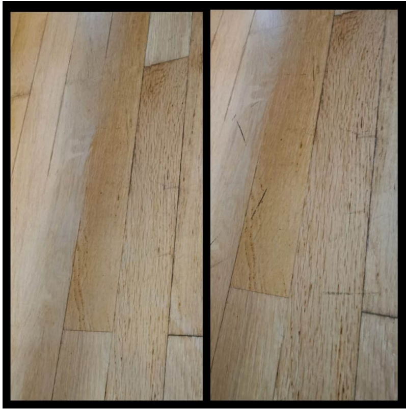
Holzboden Reinigung: links gereinigt / rechts verschmutzt
