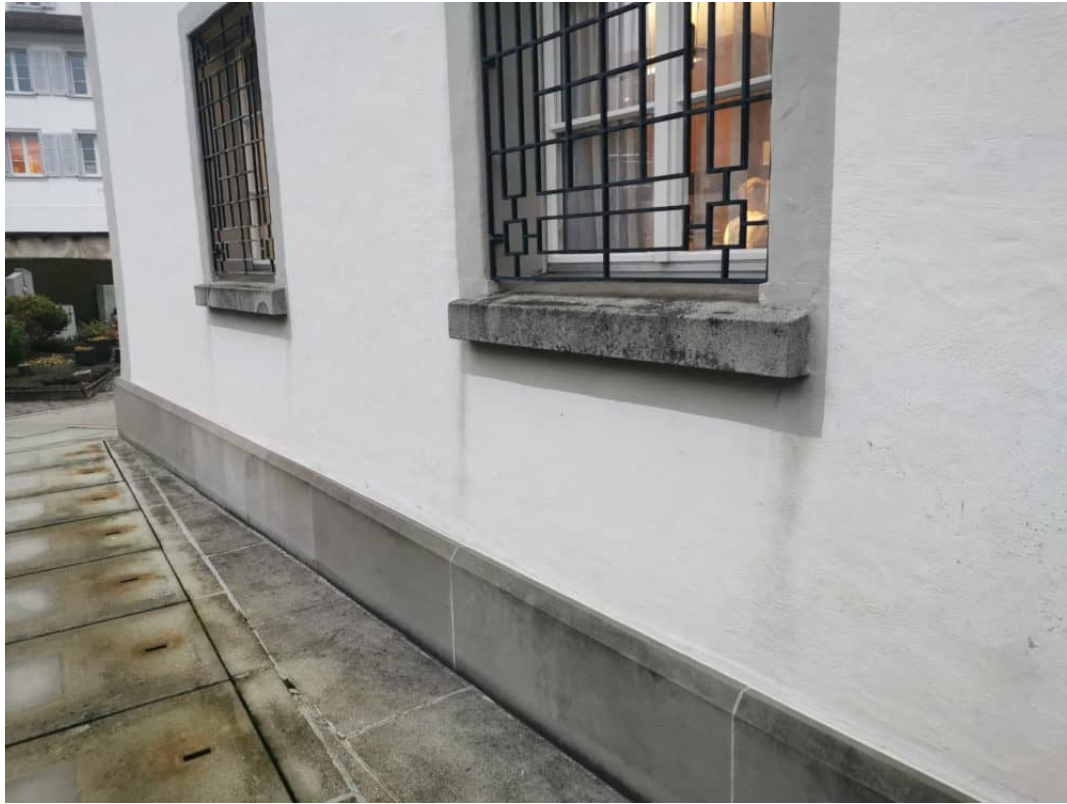
Wassernassen an Wänden werden ausgebessert
