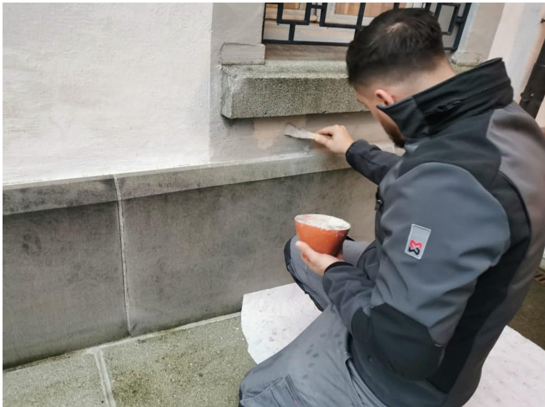
Abplatzungen und lose Putzstellen werden abgestossen, und mit Artgerechtem Material wieder angeputzt an die bestehende Oberfläche. mit Keim Mineral Farbe werden die Flickstellen örtlich Lasieret.
