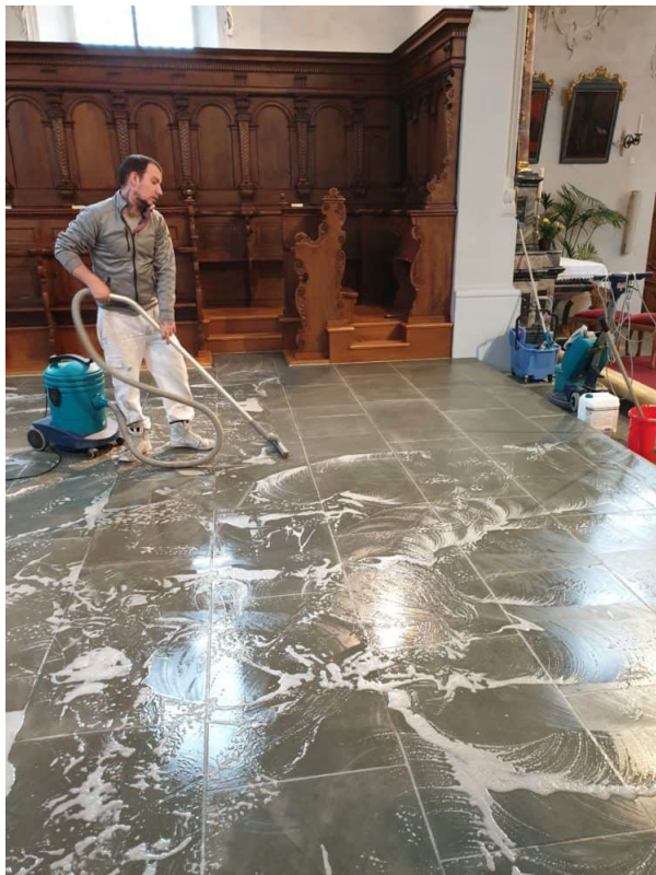
Nasses absaugen der verschmutzten Böden.
