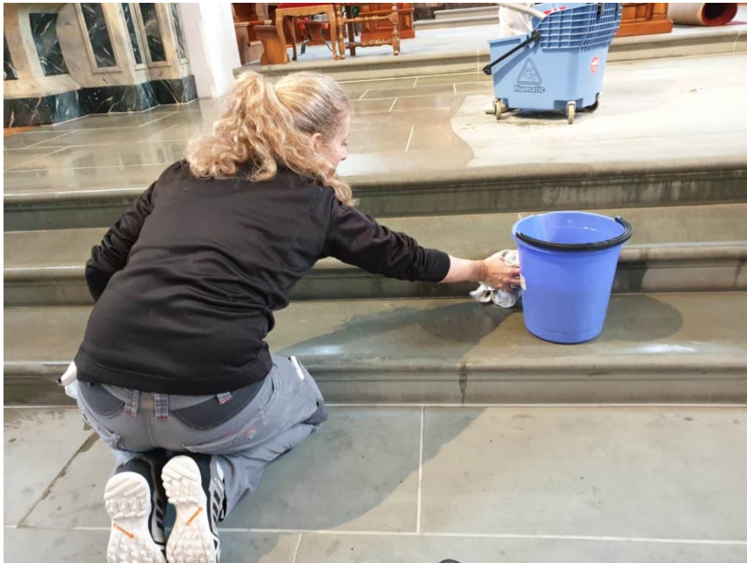
Sandstein Boden Reinigung mit Spez. Mittel Wetrok
