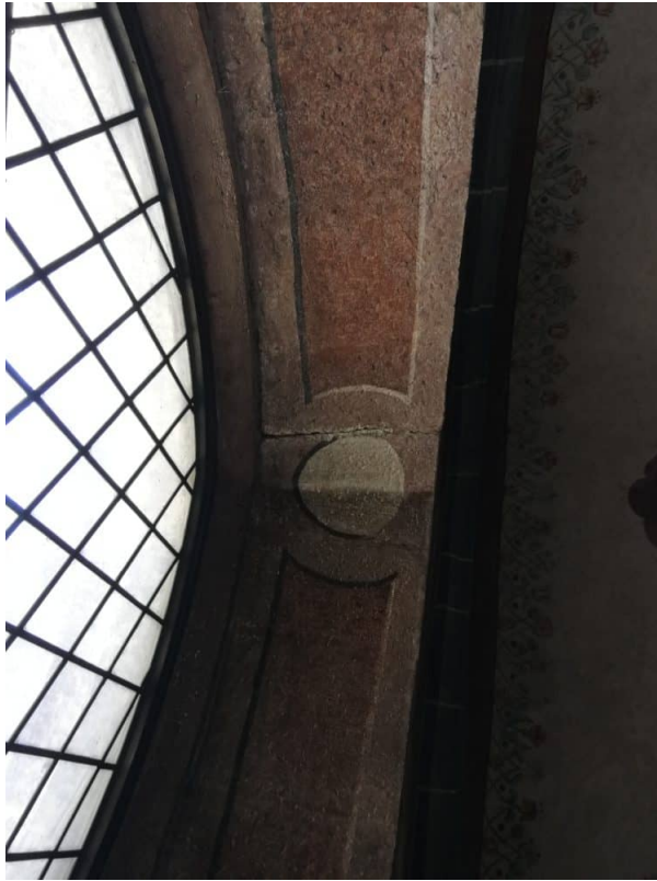
Trockenfreilegung der Fensterleibungen.
