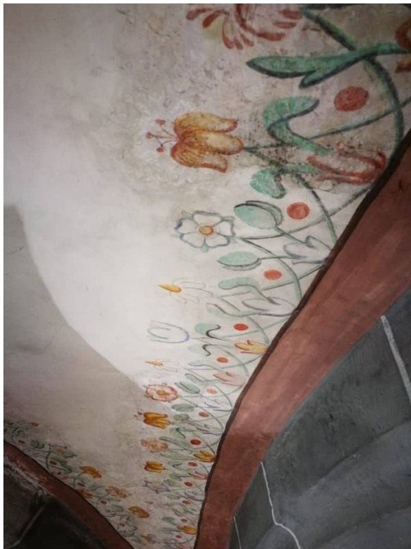
Trockenfreilegungsarbeiten am Gewölbe im Seitenschiff. Die Malereien sind gut gefestigt.
