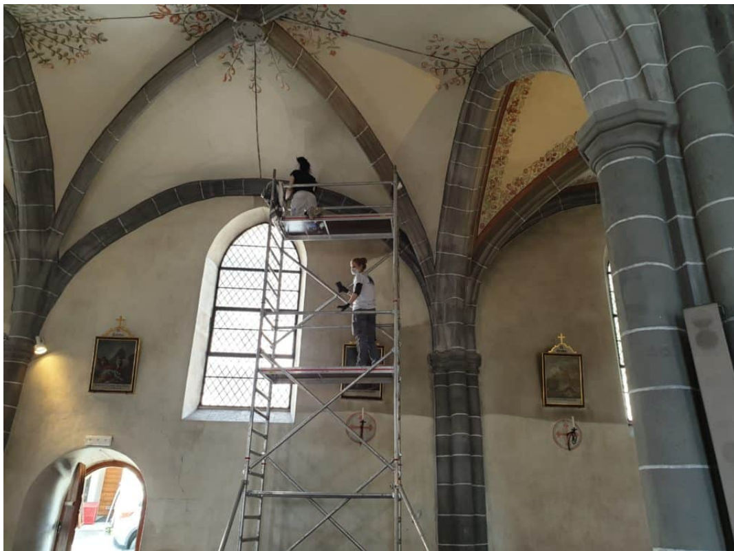
Diverse Arbeiten mit dem speziellen Rollgerüst.
