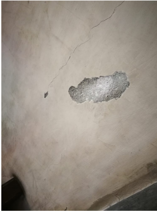
Diverse Abplatzungen des Verputzes werden mit artgerechtem Material zugeputzt und angeglichen.
