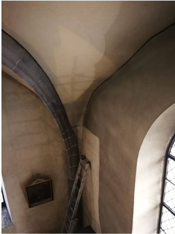
Stark verschmutzte Seitenschiffe.
