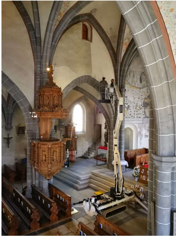
Trockenfreilegung mit speziellen Latexgummis.
