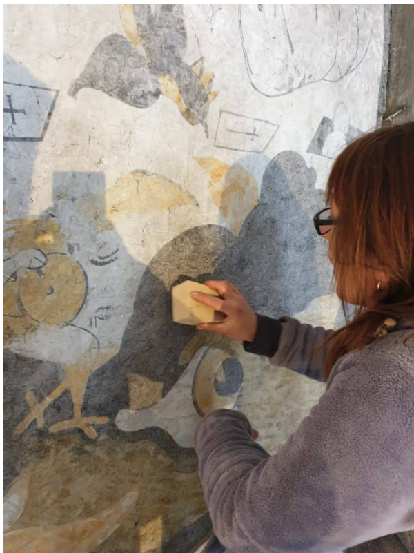
Die Trockenfreilegung der Wandbilder wurden durch die Restauratorin Karolin Wirthner fachmännisch kontrolliert und freigegeben für die Trockfreilegung mit den Latexgummis.
