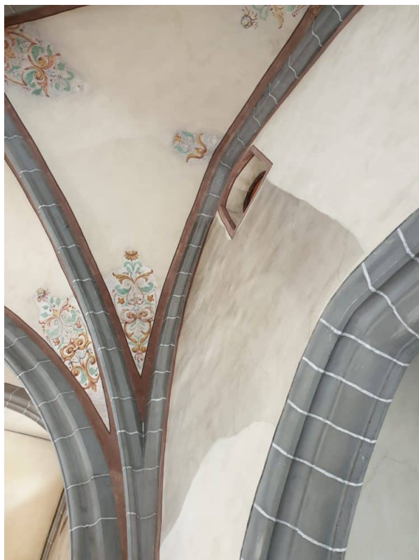
Verschmutzung im Schiff: mit kleineren Retuschen unter den Fenstern.
