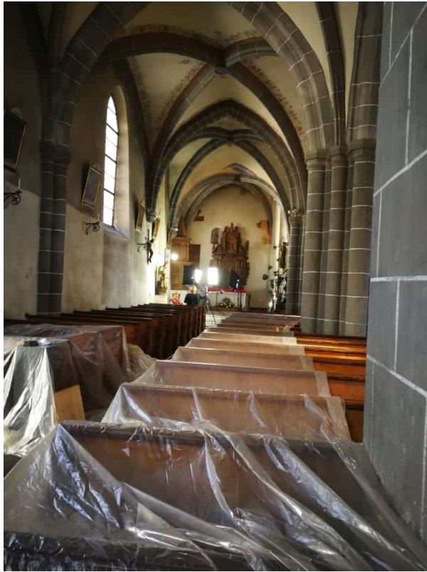
Die Seitenschiffe sind 2m hoch trocken gereinigt.
