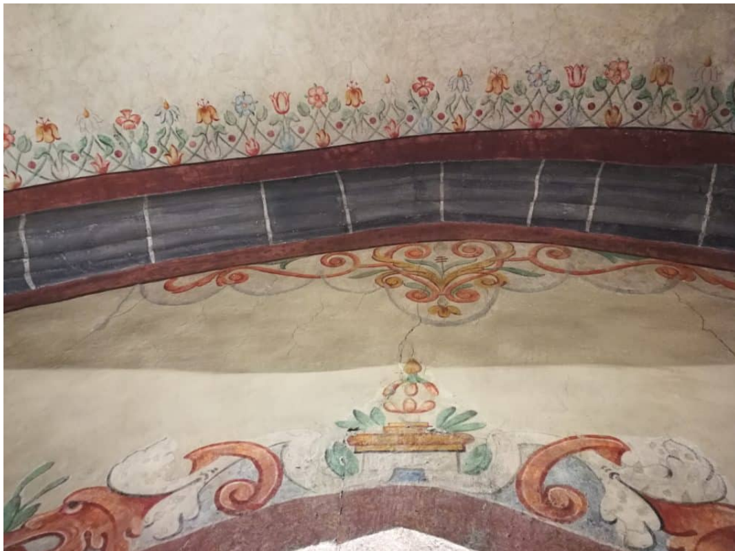
Trockenfreilegung der Fresken und Malereien.
