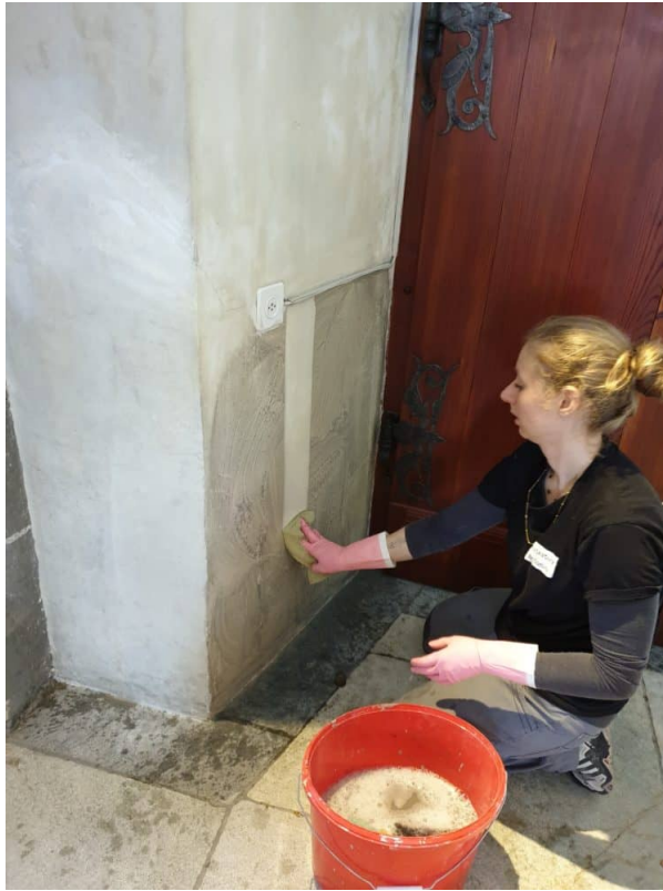
Wie mit der Denkmalpflege besprochen werden die Wände im linken Seitenschiff feucht nachgewaschen.
