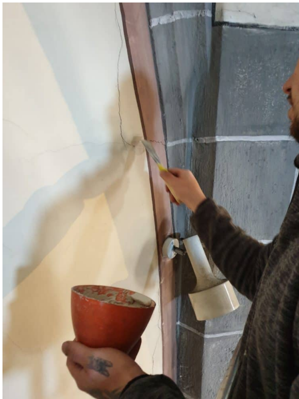
Rissanierung mit artgerechtem Material. (Marmorkalk, Sand, Cellulose, wenig Gips)
