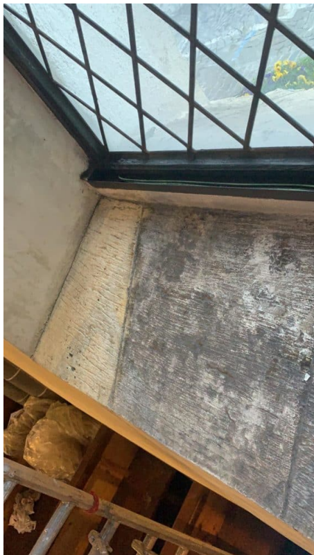
Fenstersimse werden feucht nachgewaschen.
