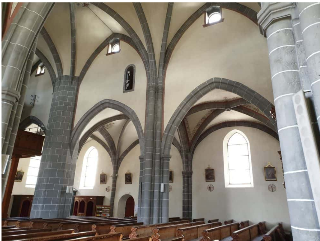
Endresultat der Trockenfreilegung und Lasur mit Kalkkasein, im linken Seitenschiff.
