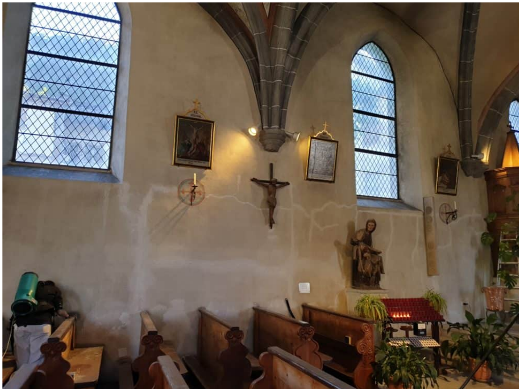
Rissanierung im linken Seitenschiff.
