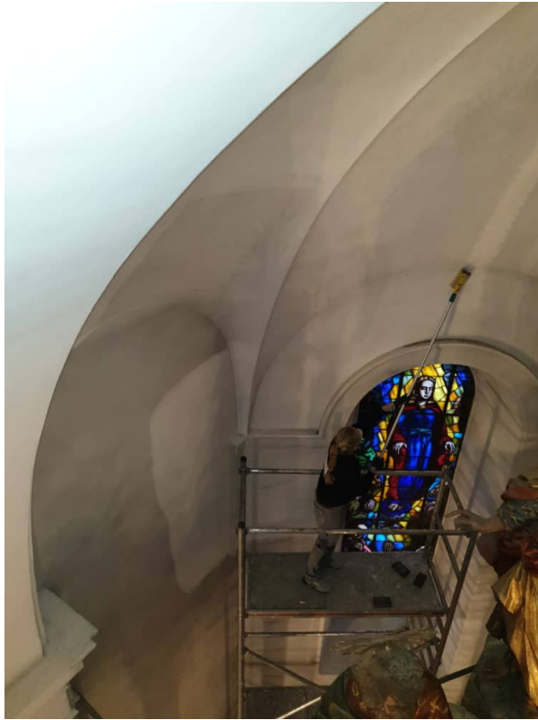
Trockenfreilegung im Chorhaus hinter dem Hochaltar.
