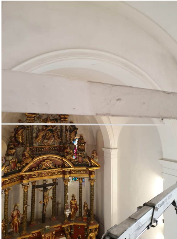
Reinigen aller Zug Stangen. Links gereinigt / Rechts verschmutzt
