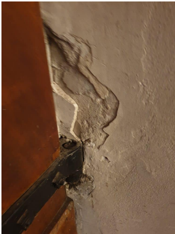
Schadstellen werden mit Artgerechtem Material zu geputzt.
