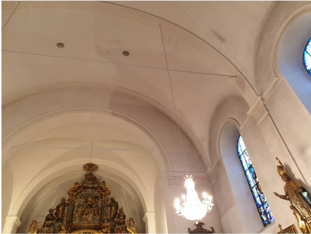
Trocken Freilegung im Schiff: Links gereinigt / Rechts verschmutzt
