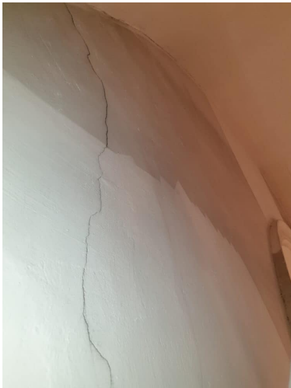
Riss Sanierung mit Artgerechtem Material.
