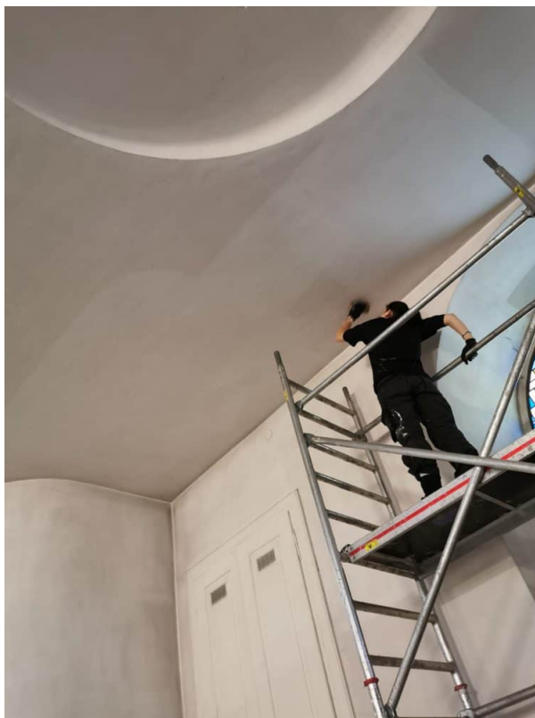
Trocken Freilegung der Emporen Untersicht.
