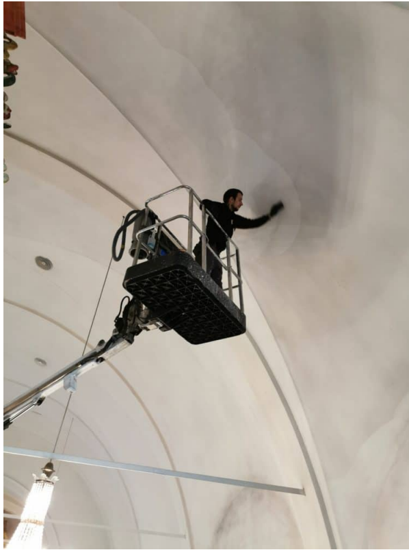
Trocken Freilegung des Gewölbes im Schiff
