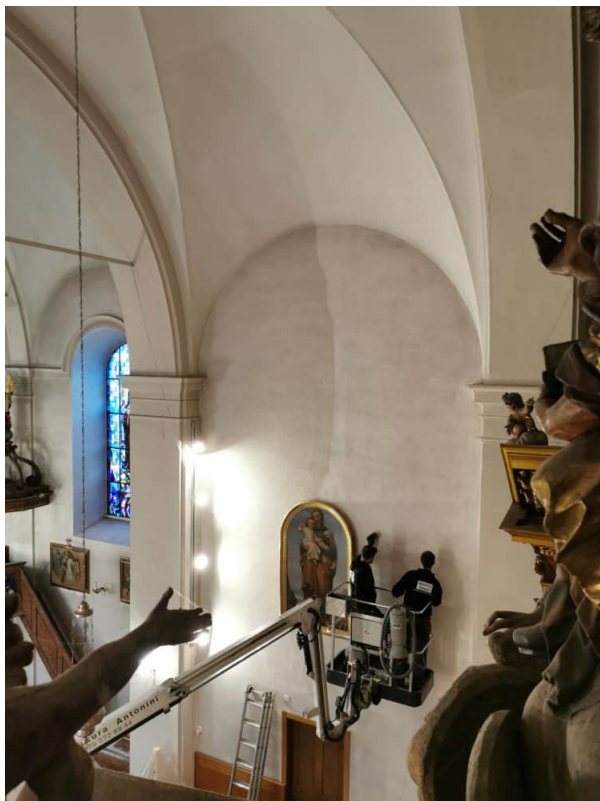
Trockenfreilegung im Chorhaus: Links verschmutzt / rechts gereinigt
