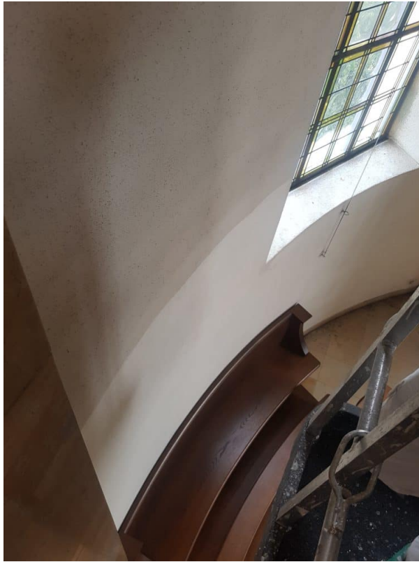
Ansicht im Chorraum.
