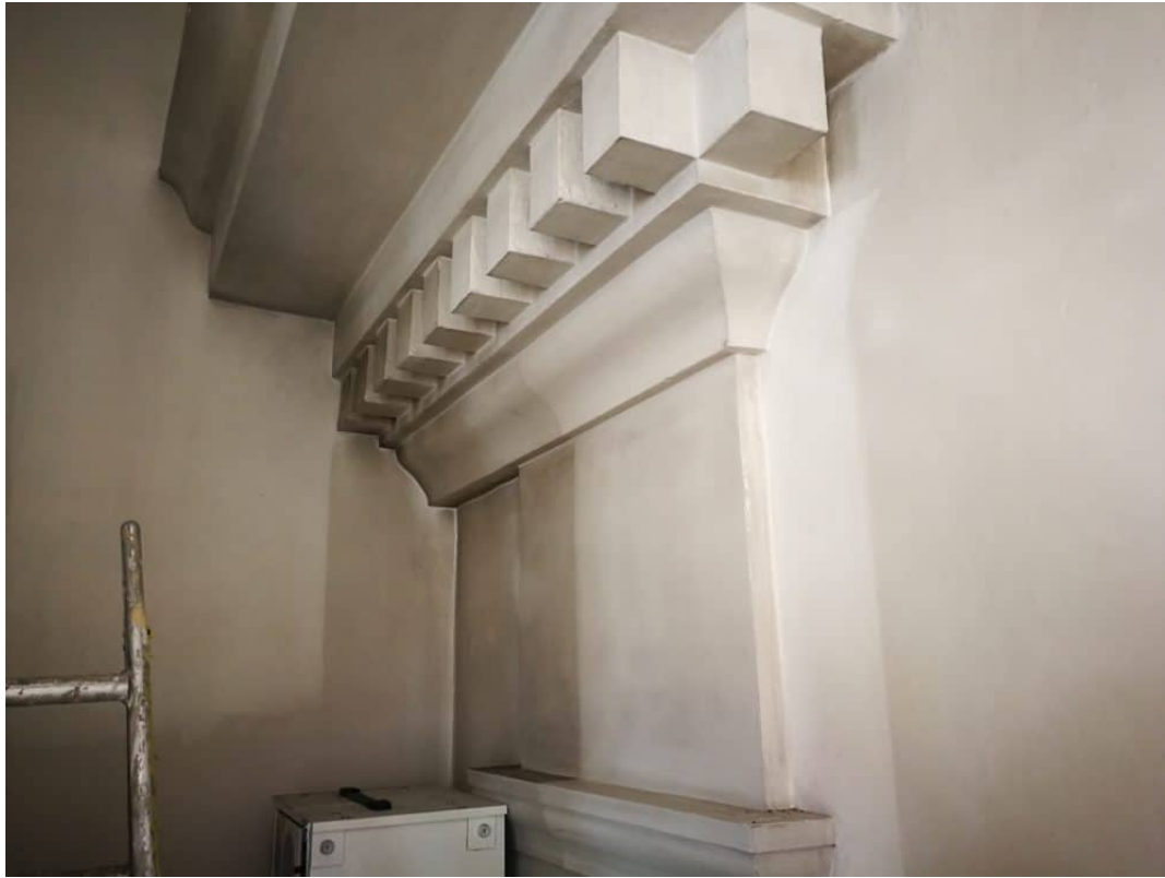
Trockenfreilegung der Lisenen und des Kämpfergesims.
