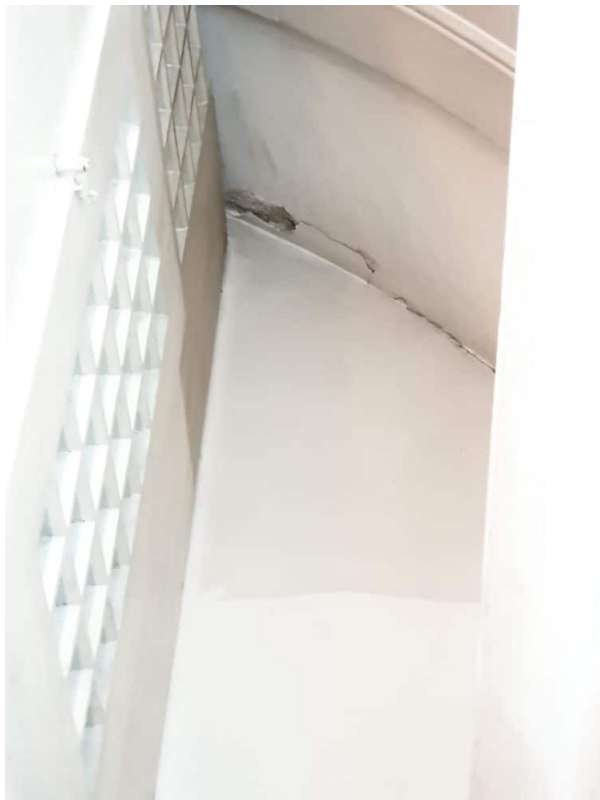
Flickarbeit bei der Orgelempore, Rechts von der Orgel, bei der Rückwand und Gewölbe. Die Flickarbeiten werden mit artgerechtem mineralischem Material zu geputzt ( Kalk, natürliche Cellulose, quarz Sand und wenig Gips), dann mit einer Mineralischen Farbe von Keim örtlich ausgebessert. ( Keim Athenit Lucente, ohne Titan Weiss.)
