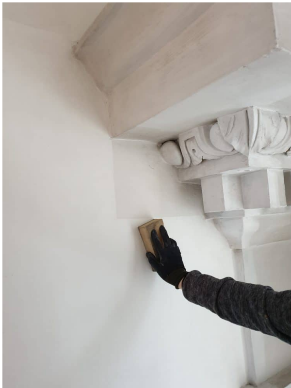
Bemusterung: Reverenz Muster im Chorraum in der Linken Nische, seitlich des Kämpfergesimses.
