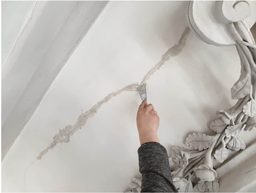
Flickarbeiten Links und Recht neben Der Kirchen Uhr, wird mit artgerechtem mineralischem Material zu geputzt ( Kalk, natürliche Cellulose, quarz Sand und wenig Gips), dann mit einer Mineralischen Farbe von Keim örtlich ausgebessert. ( Keim Athenit Lucente, ohne Titan Weiss )
