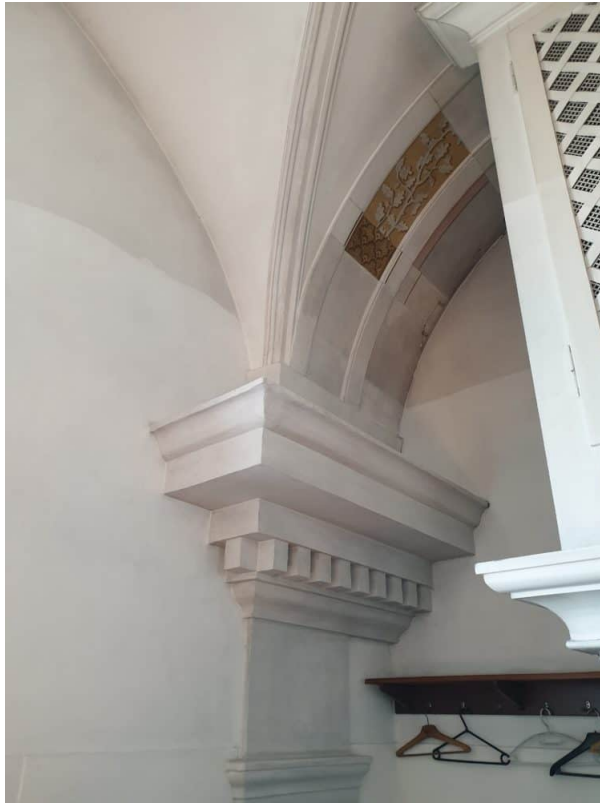
Trockenfreilegung bei der Orgelempore.
