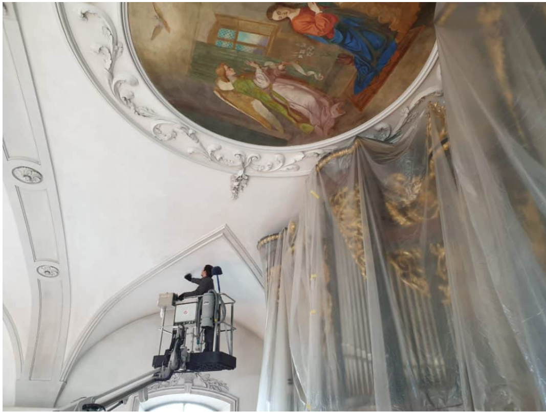
Trockenfreilegung der Stichkappe bei der Orgelempore.
