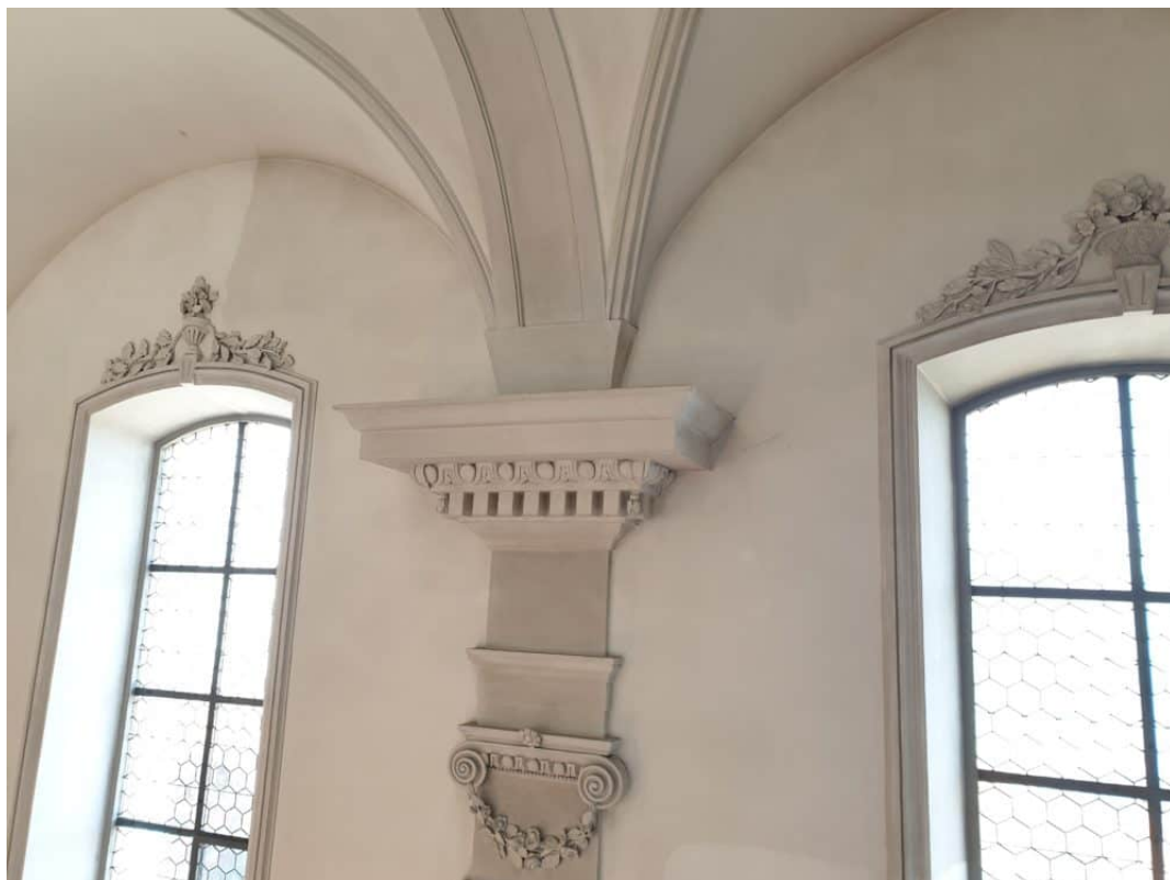
Trockenfreilegung an den Aussenwänden.
