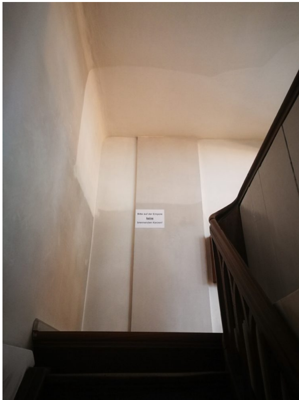
Trockenfreilegung im Treppenaufgang zur Empore
