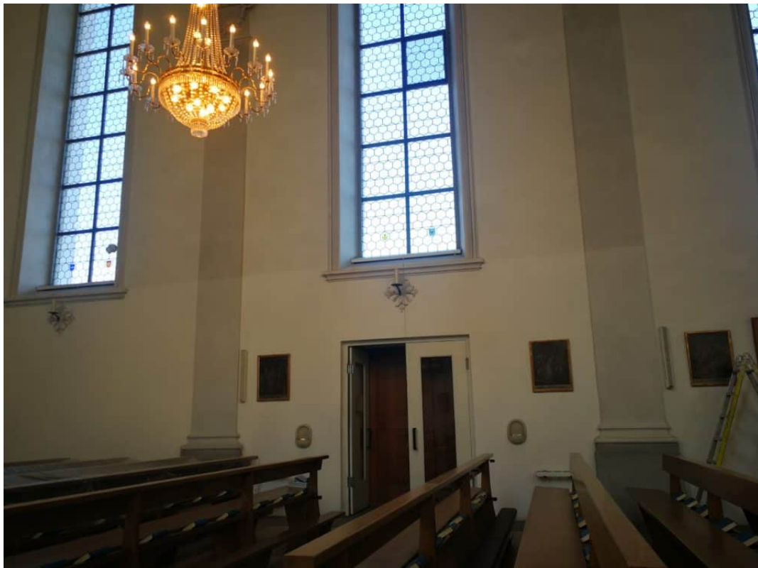
Trockenfreilegung im Schiff unterhalb bis Höhe Fenster.
