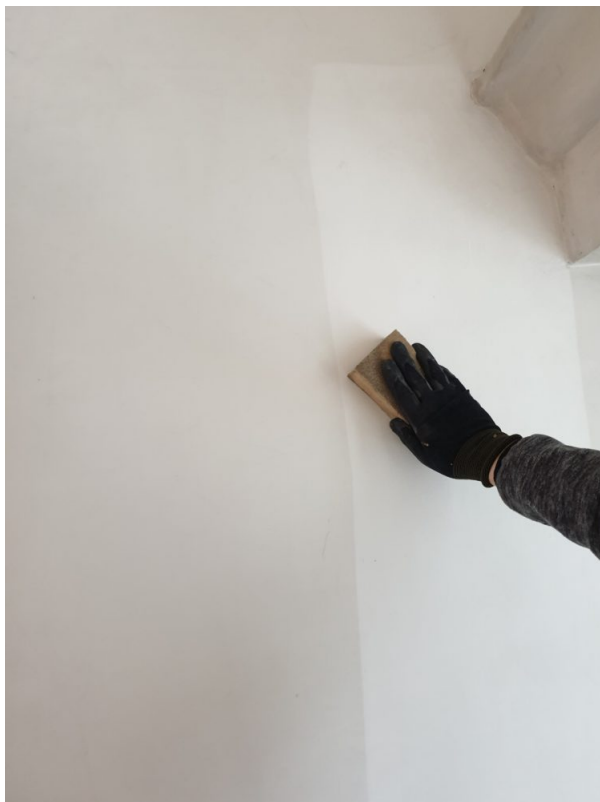
Trockenfreilegung, entfernen der Verschmutzung.
