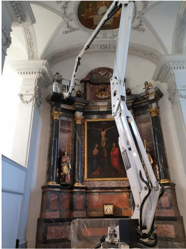
Trockenreinigung und feines absaugen des Hochaltars. mit spez. Walmaster Latex- Gummi.
