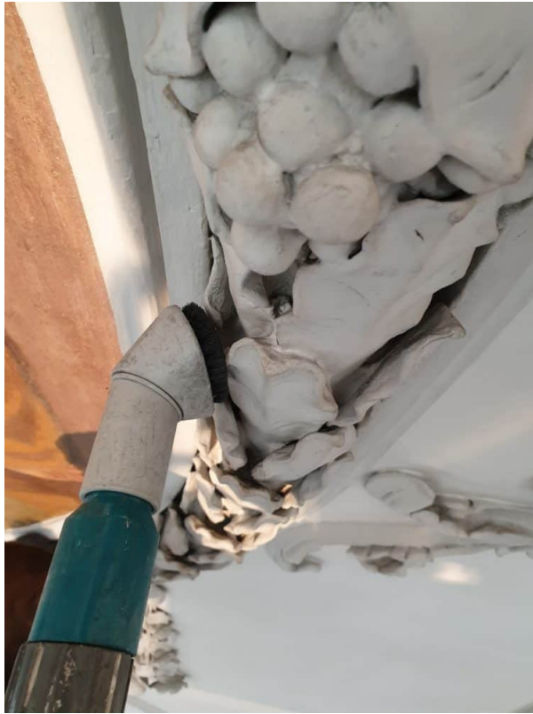
Feines Absaugen und Kontrollieren der Stuckaturen.
