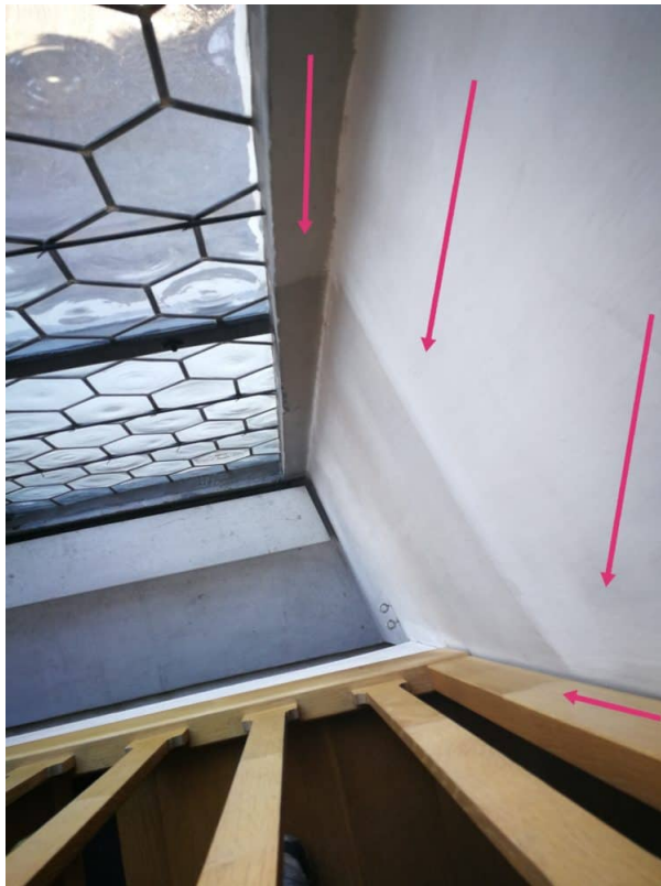
Trockenfreilegung an Fenster Leibungen und Sandstein Gewänden.
